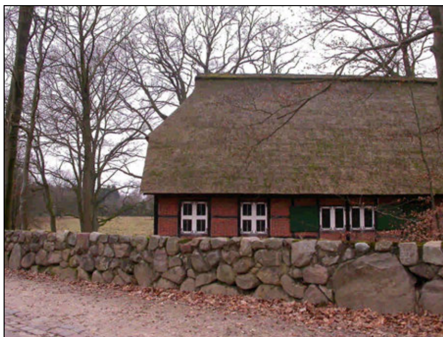
Abb. 31: Verfügte Findlingsmauer am Heimathaus in Wilsede.
