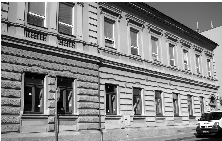
Nová okna dodají budově Mateřské školy U Parku správnou tvář.
