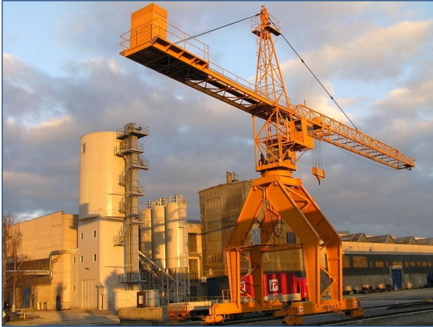
výložníkový skládkový jeřáb s obkročným portálem
