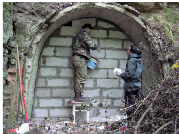
Obr. 2: Zamurovanie jedného z vchodov 3. 10. 2013, foto: Š. Danko Fig. 2. Walling up of one of the entrances on October 3, 2013, photo: Š. Danko
