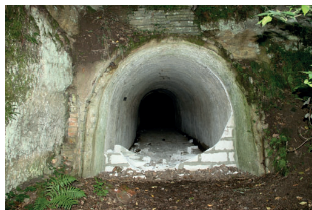
Obr. 4: Pohľad do chodby pivnice 3. 9. 2021, foto: Š. Danko Fig. 4. View into the cellar corridor 3 September 2021, photo: Š. Danko
