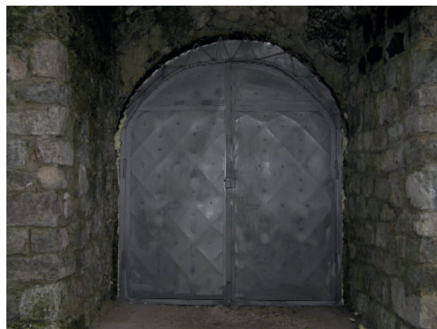
Obr. 3: Prvý vchod zatvorený majiteľom kovovou bránou 28. 7. 2014, foto: Š. Danko Fig. 3. The first entrance closed by the owner with a metal gate on 28 July 2014, photo: Š. Danko
