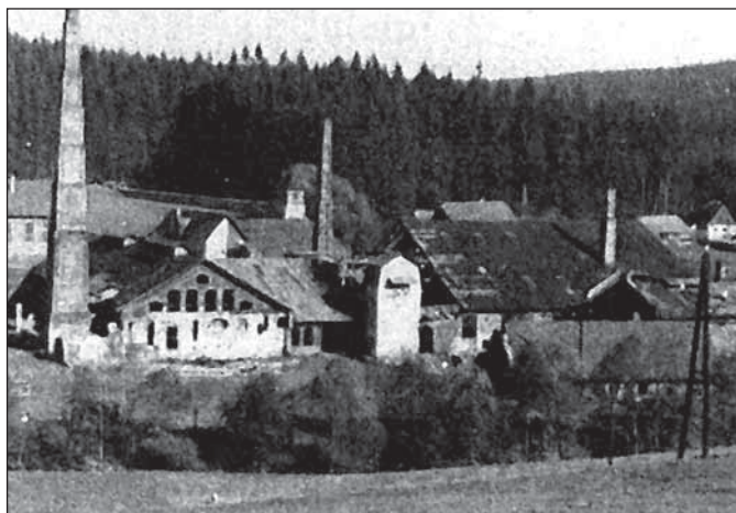
Anenská huť ve Staré Vsi, celkový pohled od jihu, stav před demolicí v roce 1955 (Foto: archiv Vlastivědného muzea Olomouc)
