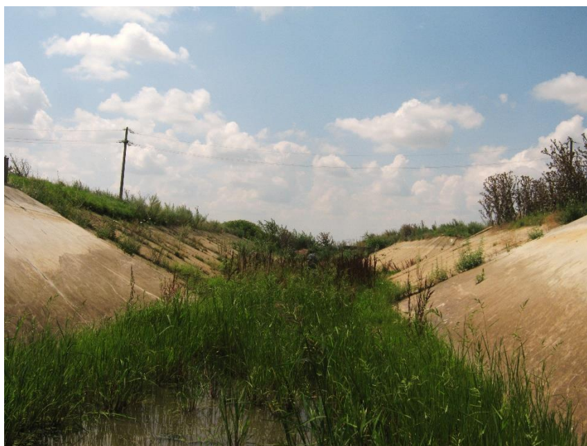
Figure 222 Irrigation canal, Libertatea Village, Călărași County (foto: Iulia Miu)
