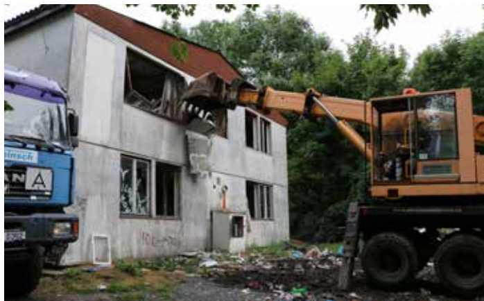
Z bourání ubytovny ve Skloněné ulici
