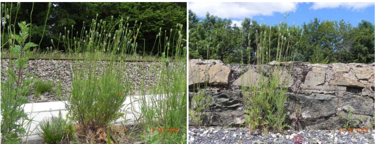
Figure 26. Deux stations de P3 : à gauche, population apparue le long d'une ligne ferroviaire après des travaux récents (Longeau, 12 juin 2020) ; à droite, cimetière de Habay-la-Neuve où P2 et P3 cohabitent (21 juin 2019).
