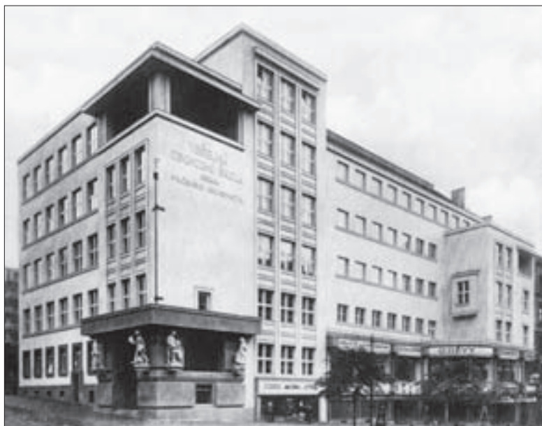
Památkově chráněná puristická budova na dnešní Vinohradské třídě vznikla v roce 1925 dle projektu Františka Kavalíra (foto po dokončení). Od roku 1955 je třetím stálým sídlem naší akademie.
