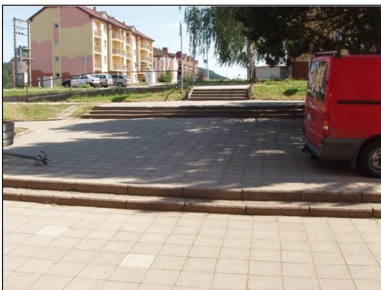
Obr. 53: Tři schodiště na trase od hlavního vstupu do školy k přechodu
