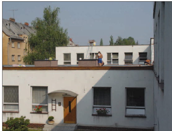
MŠ POHÁDKA: Další etapa rekonstrukce střechy. Foto: Petr Pavelka
