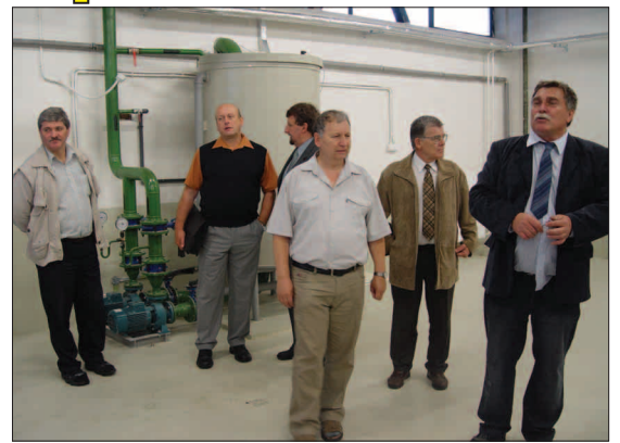
VE STROJOVNĚ: Prezentace výsledků první etapy rekonstrukce se zúčastnili zástupci médií i radnice.
