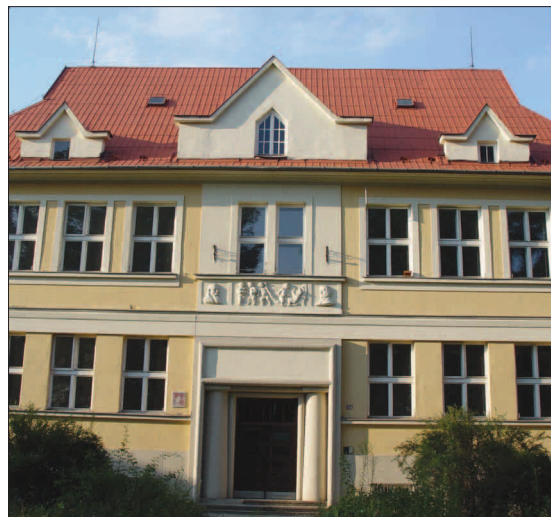
ŠKOLNÍ OBJEKT: Bývalá zvláštní škola na ulici Míru. Foto: Petr Pavelka
