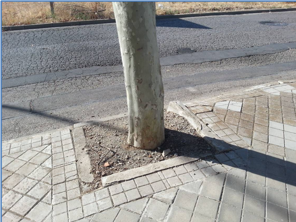
Tramo de bordillo que falta en parte exterior de la calle
