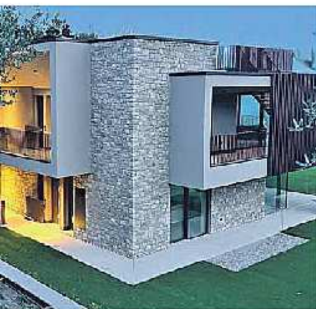
er Residence San Vigilio am Gardasee entstanden 17 Wohnungen mit in Gemeinschaftspool. Fotos: Fa. Vilgertshofer
