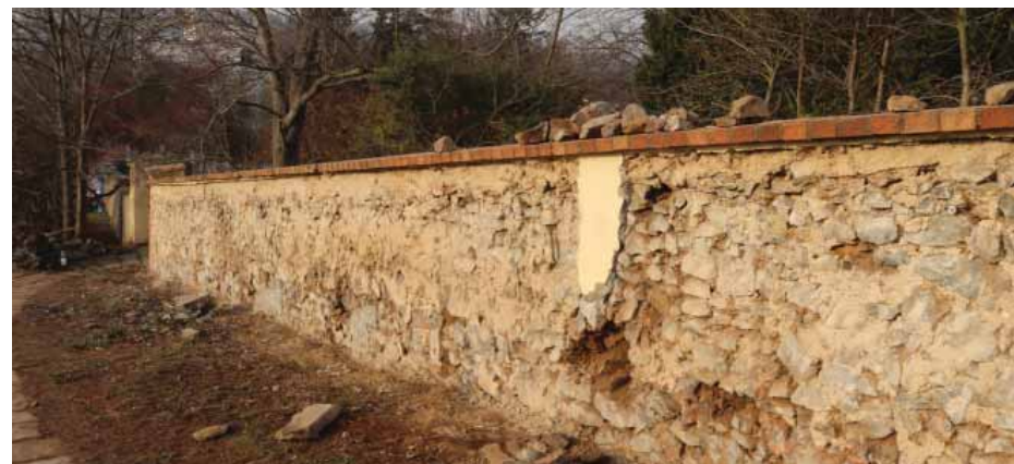
Rekonstrukce viniční zdi
