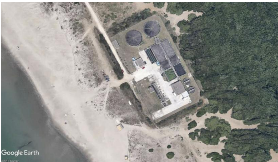
Figura 4.1.1 - Il depuratore di Cavallo Morto nel comune di Anzio (immagine da Google Earth)
