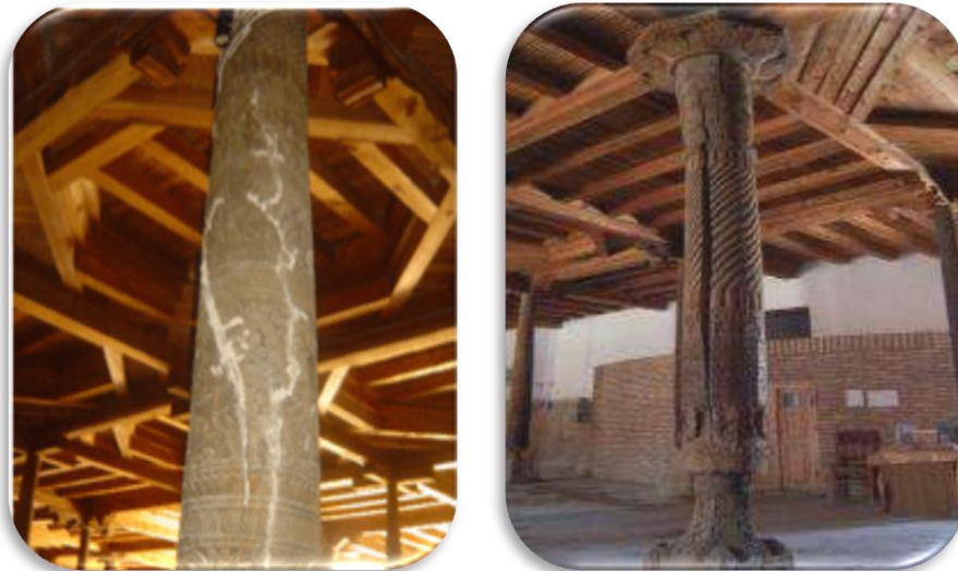
3-расм. Ёғоч устунларнинг биологик (термитлардан зарарланиш) ва физик (қийшайиш) шикастланиши
