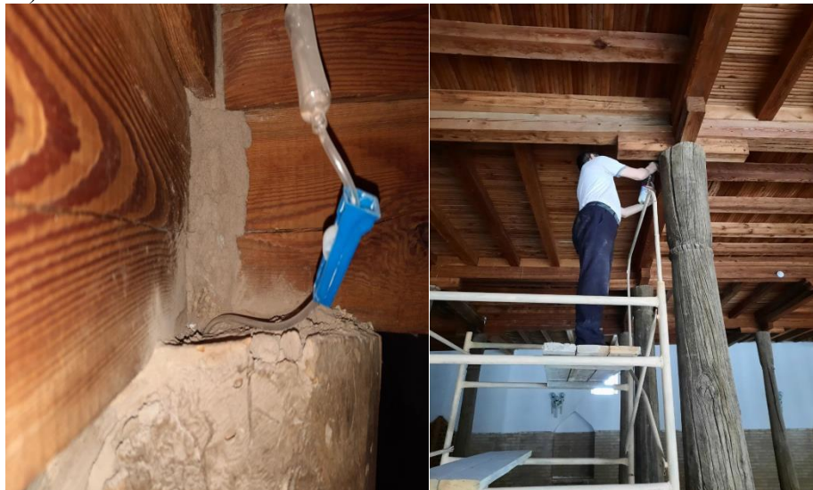
7 -расм. Термитлардан зарарланган устунларни инъекция қилиш (Жума масжид)
