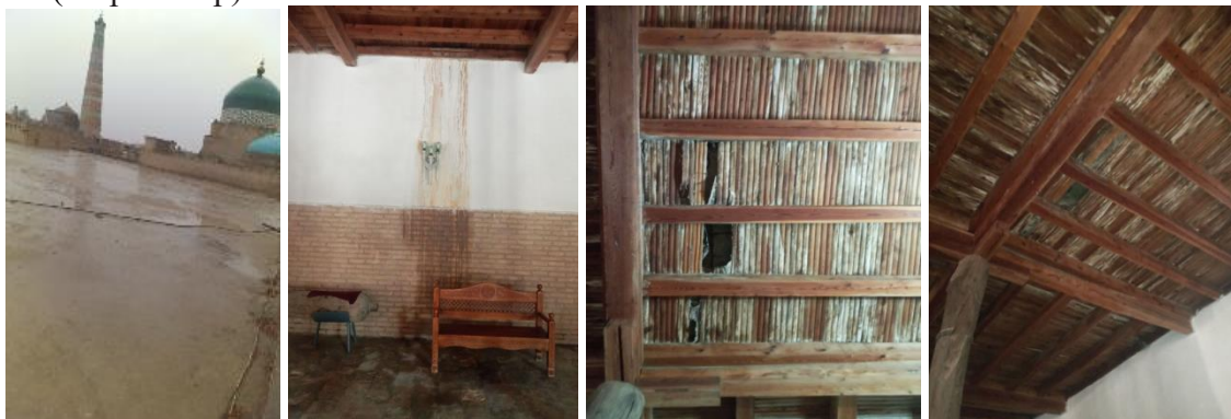
4- расм. Ёмғирнинг бино ичига ўтиши ва намликдан чириган шифт
