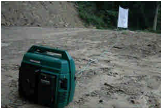
水銀燈電源由發電機提供
