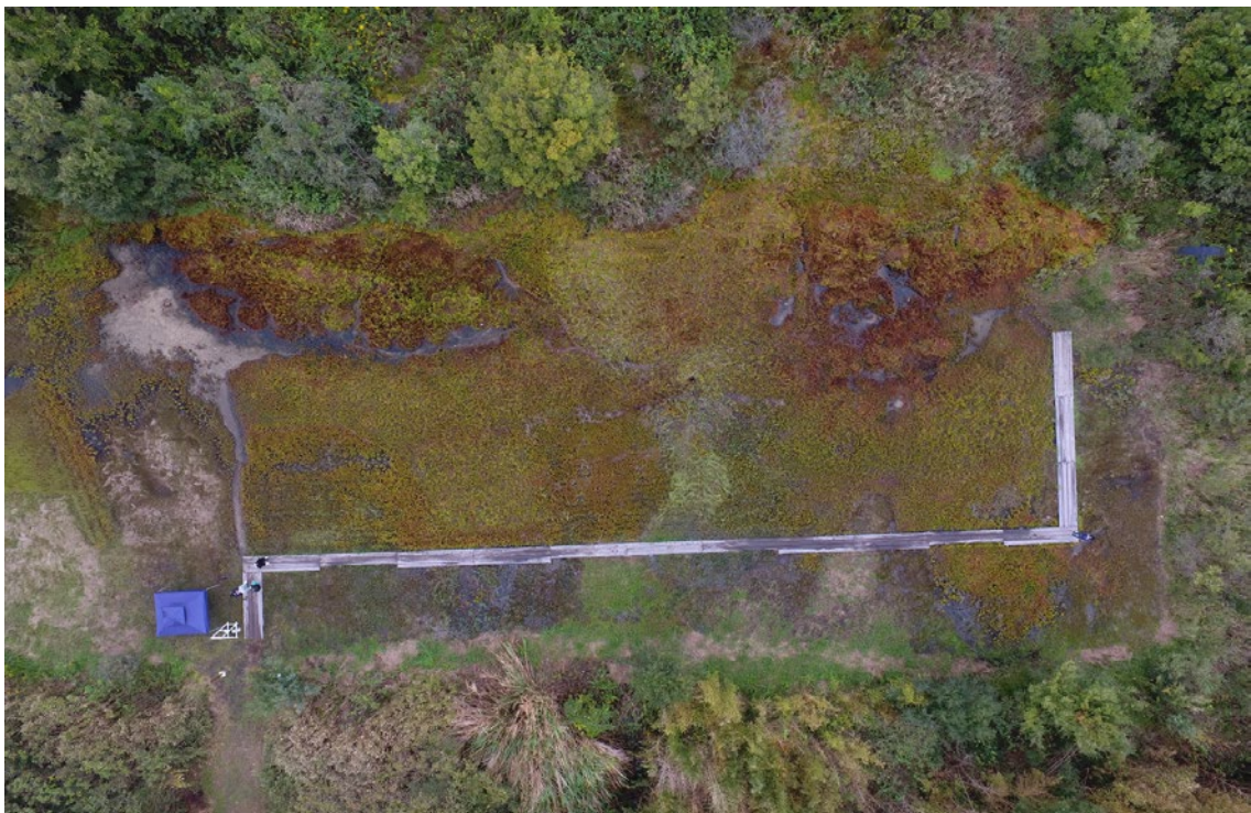
6 寄島干拓地C地区（平成 29 年 10 月 17 日）
