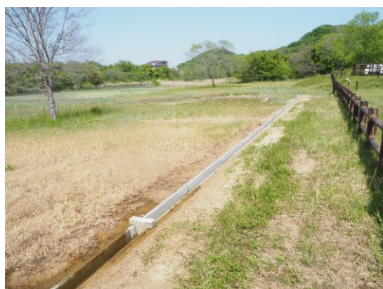
アッケシソウ自生地A地区に新たに設置された海水の給水装置
