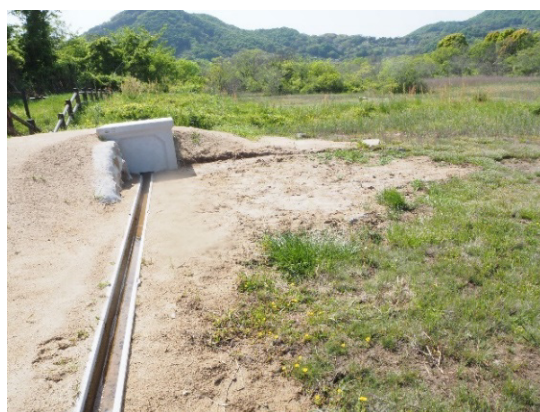
アッケシソウ自生地A地区に新たに設置された海水の給水装置
