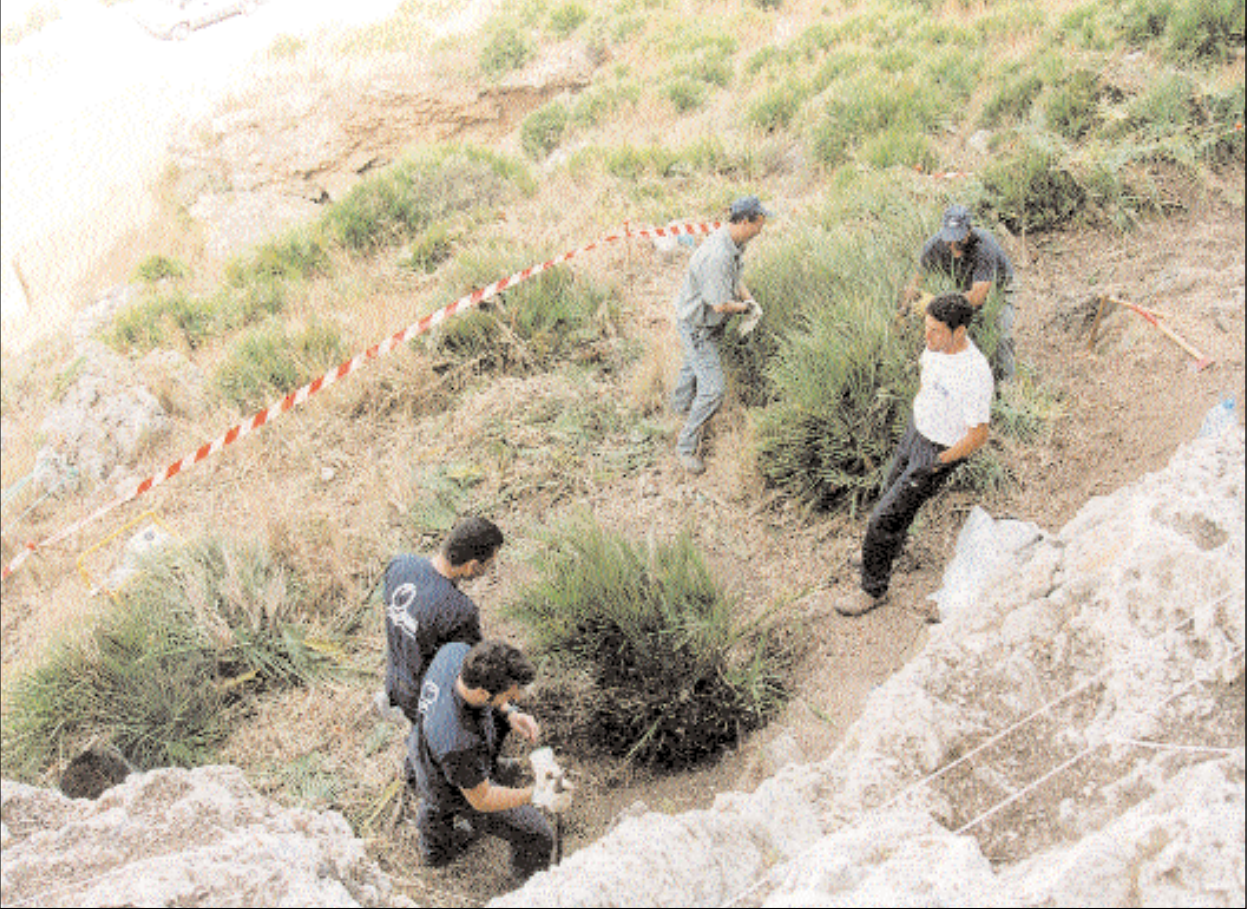
Figura 1.- Proceso de extracción y descepe de palmitos previamente al inicio de la excavación, por la brigada de Obimasa.
