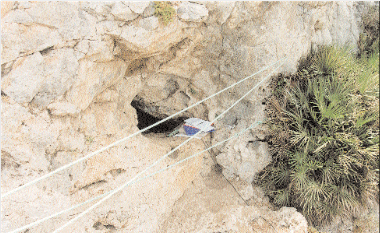
Figura 1.- Vista del acceso a la cavidad con el sistema de protección arbitrado durante el proceso de excavación.
