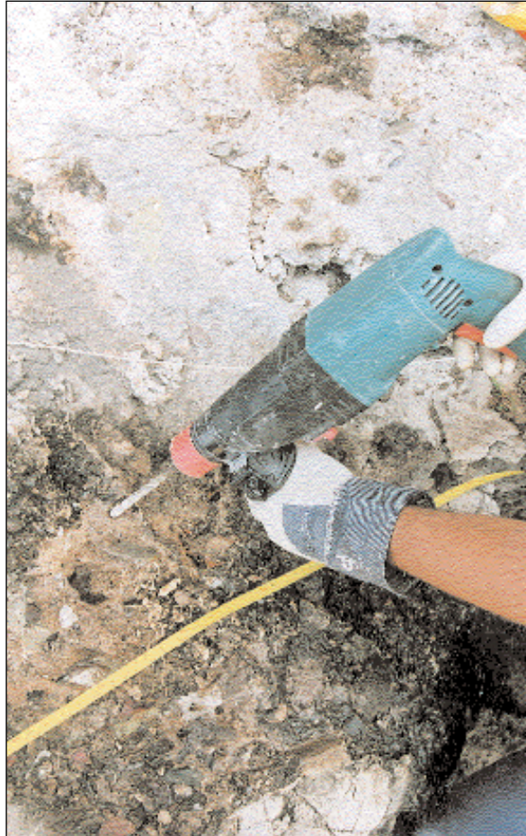
Figura 19.- Trabajos de extracción con taladro Makita HR-2410, tras aplicación de ácido clorhídrico y despeje inicial con martillo y cincel.
