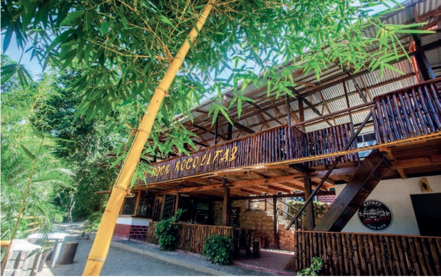
Figura 11. Construcción con bambú en Pichanaki.
