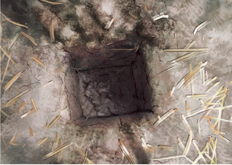
Figura 34. Hoyado para instalación del bambucillo.
