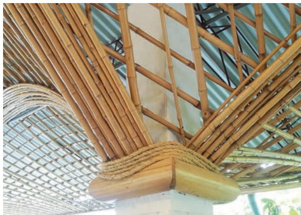
Figura 62. Integración de bambúes en decoración de columnas, restaurante Las Turunas en La Merced – Chanchamayo.
