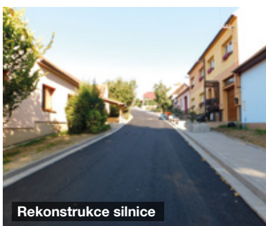
Průběh opravy silnice
