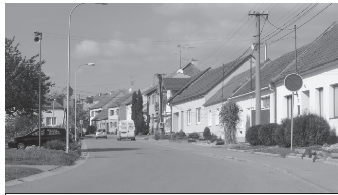
V roce 2007 až 2008 byla rekonstruována hlavní silnice od BJ čp. 236 po Tesaříkovo čp. 247 včetně nového mostu u spodní autobusové zastávky. Hodnota díla včetně chodníků, parkovacího pruhu a veřejného osvětlení činila 19 292 687,- Kč. Dále bylo realizováno prodloužení kanalizace a komunikace ke koupališti včetně parkovišti v celkové výši 1 908 019,- Kč.
