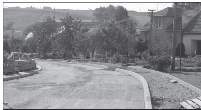
V druhé polovině roku 2010 byla zahájena stavba „Rekonstrukce komunikace pod hájenkou“ za 3 846 327,- Kč. Dále se zahajuje stavba Plocha pro recyklaci stavební suti v Janovém Dvoře s ukončením do konce listopadu. Na tuto akci byla schválena dotace z Operačního fondu životního prostředí a Evropské unie. Ta bude tvořit podstatnou část nákladů, které jsou po výběrovém řízení ve výši 9,5 mil. Kč. V letních měsících byla provedena výměna oken ve škole s nákladem 171 762,- Kč a rekonstrukce dětského hřiště za školou ve výši 200 837,- Kč.
