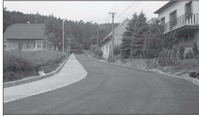
V roce 2006 až 2007 proběhla rekonstrukce komunikace od zrcadla po fotbalové hřiště. Celková částka za provedené opravy včetně nové kanalizace a veřejného osvětlení byla 14 086 421,- Kč.
