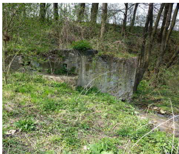
Obr. 11-6 Splav z rybníka Trubného. Vpravo protéká část, vlevo původní dno rybníka s opevněním hráze a viditelnými otvory pro nosníky dřevěných prvků – lávky nebo stavidel (foto Jindřich Frajer, 2021).
