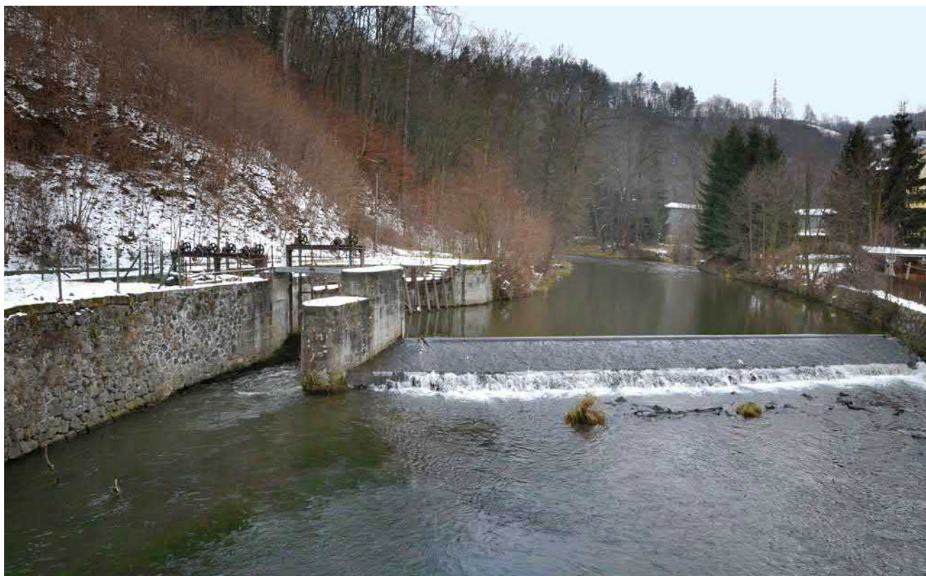
Obr. 10-38 Františkov nad Ploučnicí, přádelna č. p. 25, jez a nátok se stavidly do náhonu (foto Miroslav Kolka, 2021).
