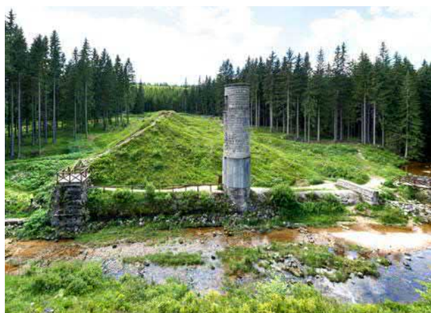
Obr. 3-4 Přehrada Bílá Desná (KP), vystavěná v letech 1911–1915 a protržená rok po dokončení (foto Viktor Mácha, 2020).
