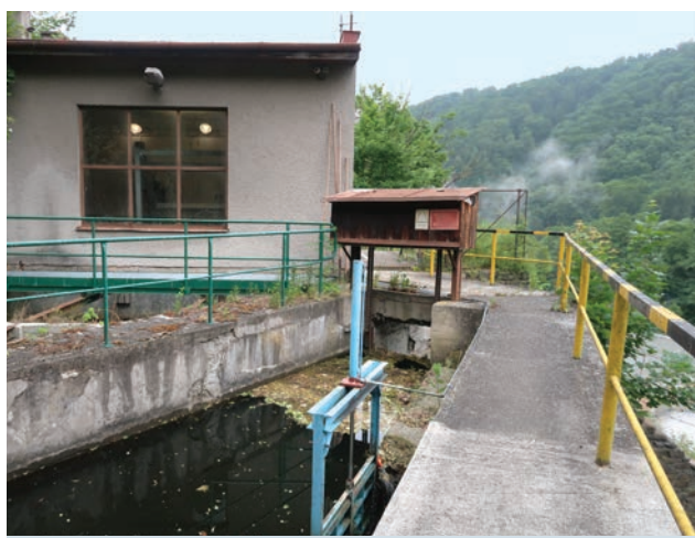
Obr. 8-28 Vtokový objekt s pevnými a pohyblivými stavidly v současnosti (foto Radka Račoch, 2021).
