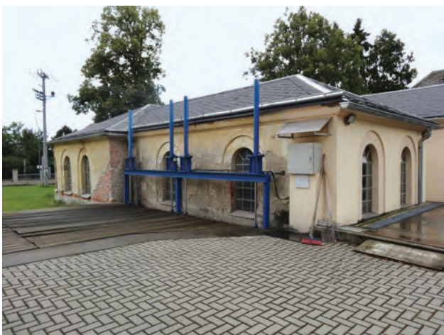
Obr. 9-9 Objekt MVE Červený dvůr – zděná česlovna (foto Renata Pavelková, 2021).
