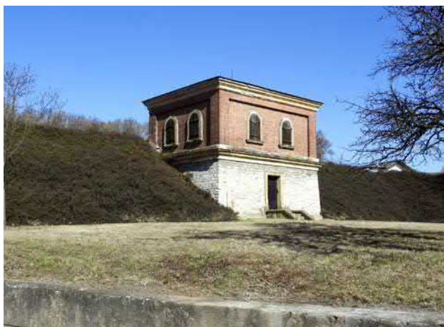
Obr. 3-8 Olomouc, dvoukomorový zemní vodojem z cihelného zdiva, vystavěný spolu s parní čerpací stanicí ve Chválkovicích na cca 8 km vzdáleném Tabulovém vrchu. Na rozdíl od čerpací stanice není památkově chráněn (foto Michaela Ryšková, 2022).
