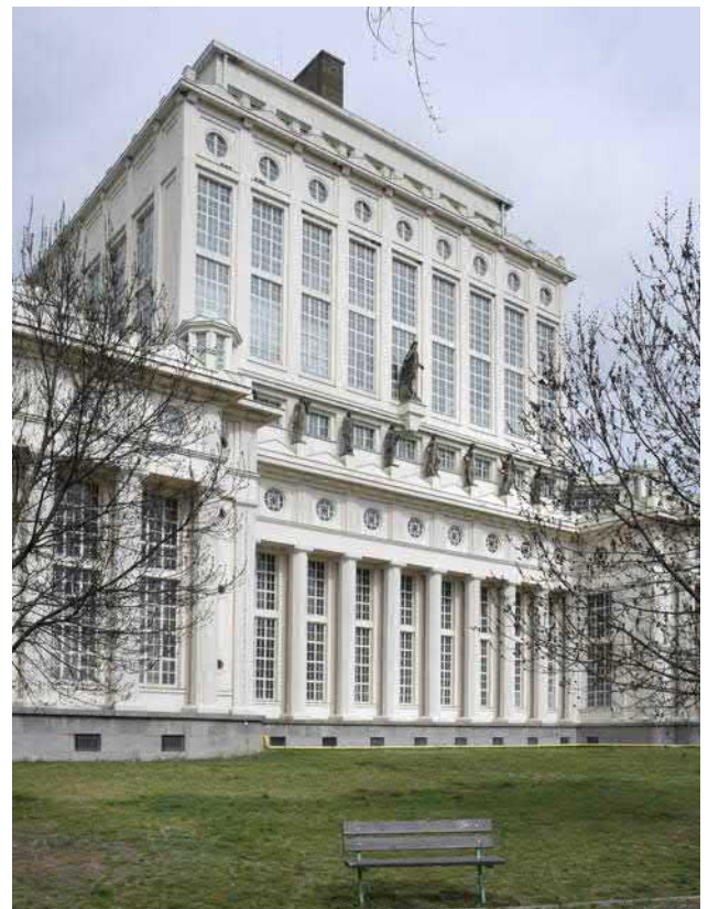
Obr. 3-12 Praha, úprava vody Podolí z let 1929–1931 a 1959–1962 (KP) je dílem arch. Antonína Engela, prof. Bedřicha Hacara a prof. Františka Kloknera. Jižní průčelí z druhé fáze výstavby úpravy zdobí soubor soch znázorňující Vltavu a její přítoky (foto Michaela Ryšková, 2022).
