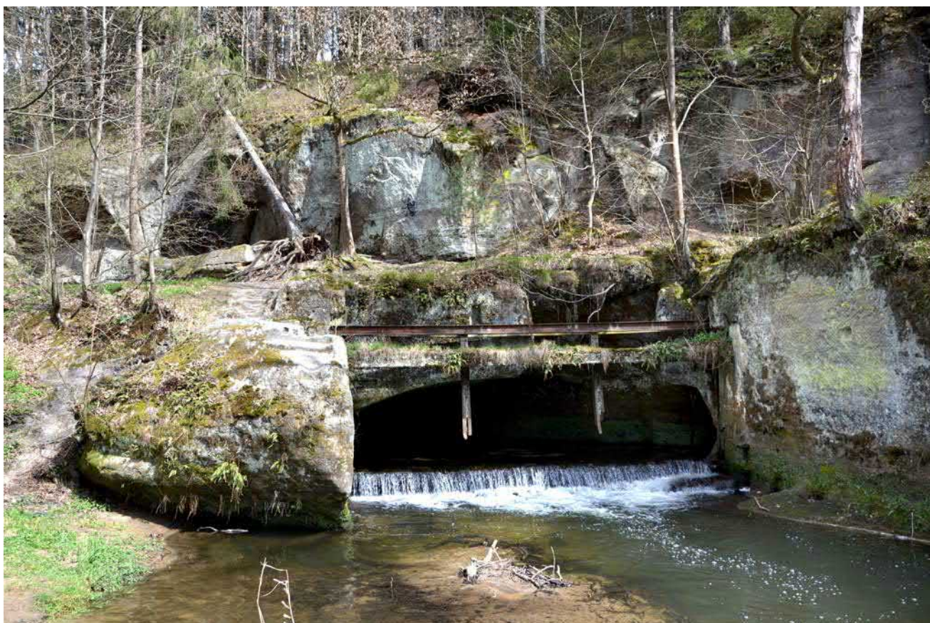
Obr. 10-16 Jez vodního díla brusírny a leštírny zrcadel č. p. 309 a 311 v Lindavě. Práh je osazen mezi přisekané skalní stěny. Voda na jez přitéká z levé strany krátkou zalomenou štolou mimořádných parametrů. Náhon odbočuje opět skalní štolou před jezem směrem doprava. Stavidlový jez pochází z úpravy, provedené v roce 1917 (foto Miroslav Kolka, 2020).
