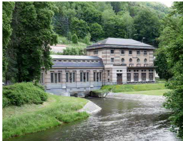
Obr. 4-4 Spálov, vodní elektrárna. Soubor budov vodní elektrárny z let 1921–1926 v tzv. „národním stylu“ je dílem architekta geometrické secese a kubismu Emila Králíčka (Lukeš a kol., 2005; KP) (foto Michaela Ryšková, 2022).
