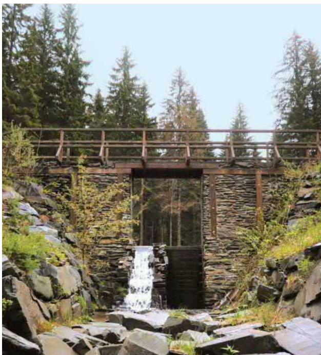
Obr. 8-9 Průtočná část hráze obnovené klauzy na Splavském potoce (foto Martin Caletka, 2021).
