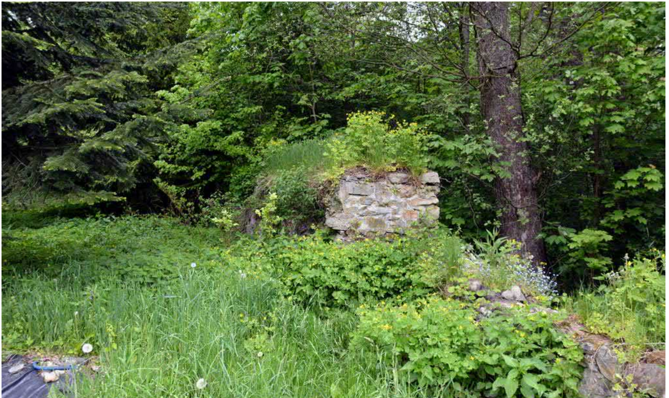
Obr. 9-7 Ruina silotvorného objektu s pozůstatky kolové komory Rotterova mlýna (foto Renata Pavelková, 2021).
