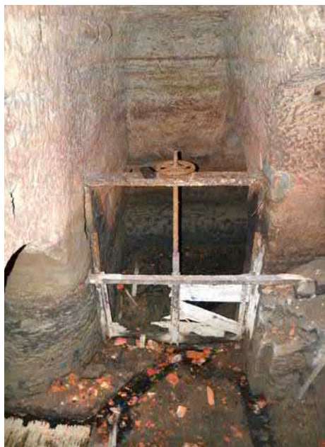
Obr. 10-18 Brusírna a leštírna zrcadlární č. p. 308 v Lindavě. Vlevo koncová část náhonu s torzem stavidla a česle a stavidlem do jalové obtokové skalní štoly, lednice je vpravo (foto Miroslav Kolka, 2020).
