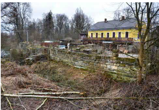
Obr. 10-3 Brenná, mlýn č. p. 37, mohutný náhon z Ploučnice ústí do lednice a později turbínové kašny u torza základů zdiva mlýnské budovy, vlevo mimo záběr stála na druhé straně náhonu pila, v pozadí obytná budova (foto Miroslav Kolka, 2019).
