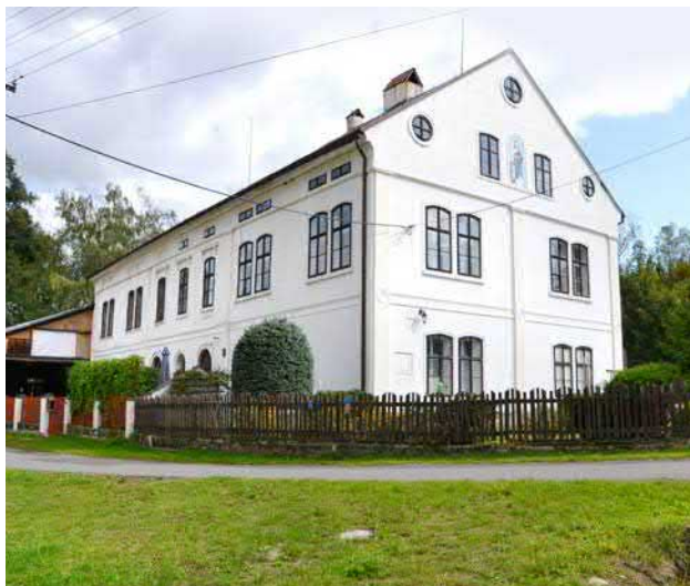
Obr. 10-14 Celkový pohled na mlýn č. p. 87 v Lindavě, náhon přitéká od odvrácené strany, vpravo dole vyústění odtokového kanálu (foto Miroslav Kolka, 2019).
