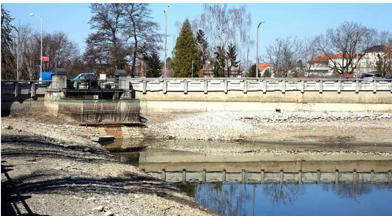
Obr. 11-20 Pohled na návodní stranu hráze rybníka (částečně vypuštěn). Vlevo stavidlo rybníka, vpravo uprostřed relikv potrubí přivádějícího vodu na mlýnské vantroky (foto Jindřich Frajer st., 2022).
