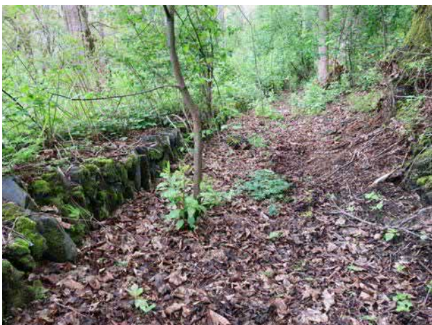
Obr. 8-2 Pozůstatek koryta náhonu s opevněním břehu z břidlice u Malé Štáhle (foto Martin Caletka, 2021).
