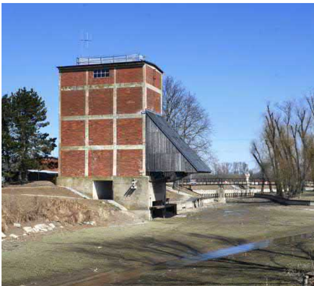
Obr. 4-1 Baťův kanál byl součástí energetického systému Baťových závodů ve Zlíně. Je funkčním celkem zahrnujícím řadu objektů zajišťujících dopravu lignitu z dolů v Ratíškovcích k závodní elektrárně v Otrokovicích. Jeho součástí jsou umělé toky, jezy, plavební komory a další objekty na této vodní cestě, včetně obytných domů pro zaměstnance. Na snímku výklopník uhlí do nákladních člunů v Sudoměřicích (foto Michaela Ryšková, 2022).
