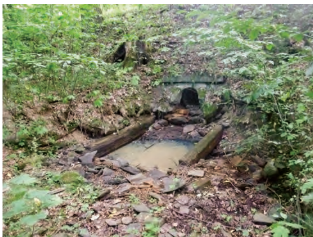
Obr. 11-30 Podtrubní jáma Nového rybníka na návodní straně hráze (foto Jindřich Frajer, 2018).
