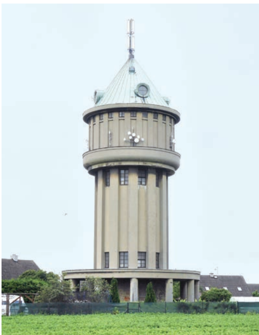
Obr. 3-11 Jaroměř, věžový vodojem z roku 1928 (KP), postavený podle návrhu arch. Františka Jandy, byl vybudován v rámci vodárenského systému, který pro město navrhl Ing. Jan Vladimír Hráský (foto Michaela Ryšková, 2022).
