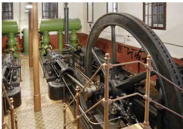
Obr. 3-7 Olomouc, parní čerpací stanice Chválkovice, vystavěná roku 1889 na kvalitním zdroji podzemní vody mezi Chválkovicemi a Černovírem pro zásobování města Olomouc. V provozu byla do roku 1960. Zachována a památkově chráněna je strojovna vybavená původními parními stroji (KP), vybavení kotelny bylo zlikvidováno. Při příležitostných prohlídkách jsou parní stroje poháněny stlačeným vzduchem (foto Michaela Ryšková, 2022).
