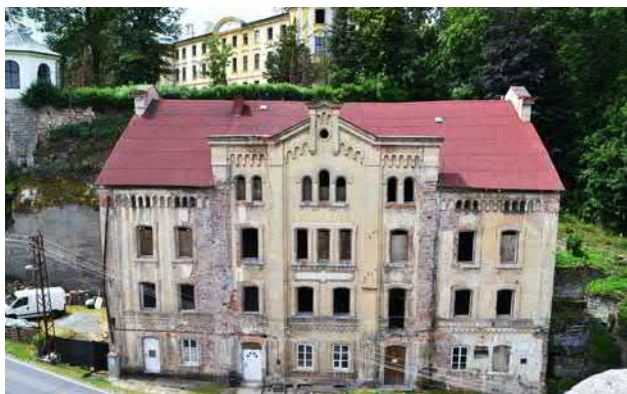
Obr. 10-6 Zahrádky, mlýn č. p. 34, mohutná historizující budova z roku 1865 stojí pod zámeckou ostražnou, zařízení poháněla dvě kola na horní vodu, umístěná před v lednici před průčelím, dlouhý náhon ke mlýnu vedl až od dolního konce Novozámecké průrvy, na pravé nároží navazovala zaniklá čerpací stanice zámeckého vodovodu (foto Miroslav Kolka, 2020).
