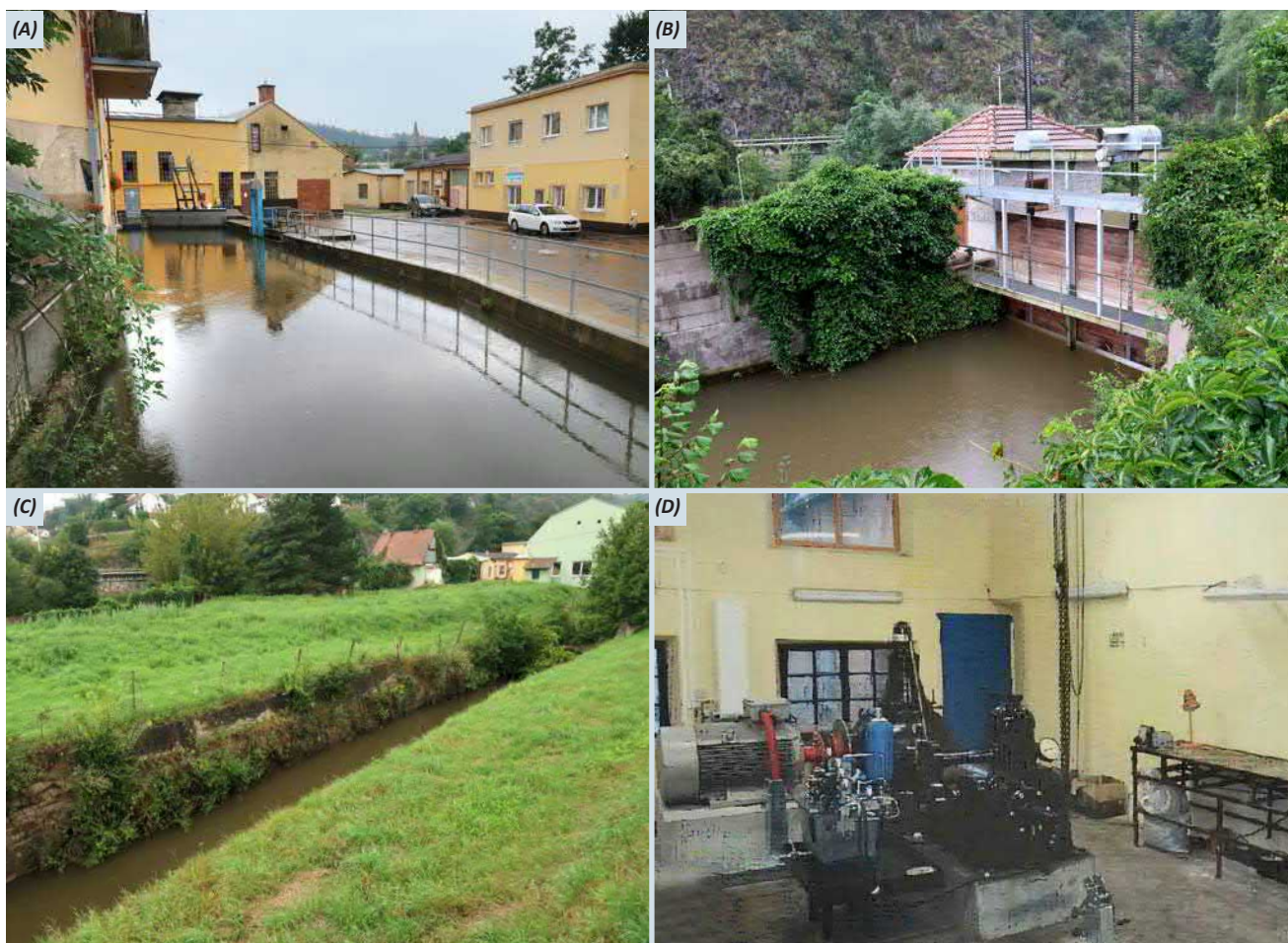
Obr. 7-18 Mlýn a malá vodní elektrárna v Bílovicích nad Svitavou – (A) vtok náhonu do turbíny, (B) hradící objekt na počátku náhonu, (C) charakter koryta náhonu, (D) interiér strojovny (foto A–C Miriam Dzuráková, 2020; D Manipulační řád MVE Bílovce nad Svitavou).
