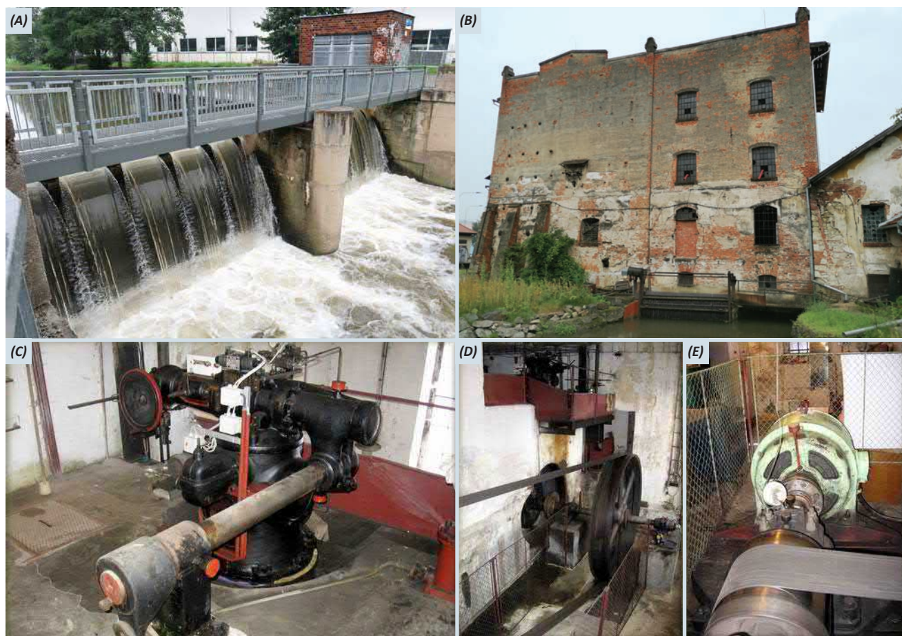
Obr. 7-16 Mlýn a malá vodní elektrárna v Blansku – (A) jez na Svitavě, (B) budova bývalého mlýna v stoku na turbínu a jalovou propustí, (C) interiér strojovny – regulační zařízení, (D) interiér strojovny – oběžné kolo s gumovou transmisí, (E) interiér strojovny – generátor (foto A–B Miriam Dzuráková, 2020; C–E David Varner, www.davar.cz/badatelna , 2009).
