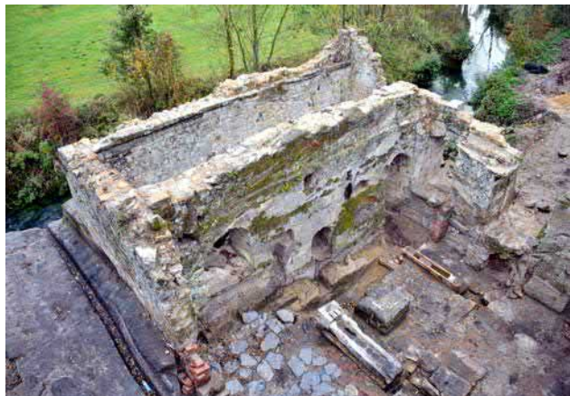
Obr. 10-4 Velký Grunov, kostní stoupa a olejna v usedlosti č. p. 95, pohled na vykopané torzo stavby před opětovným zastřešením, krátký náhon na levém břehu Panenského potoka ústí do mohutné lednice, kde bylo osazeno vodní kolo na spodní vodu, vpředu odkrytá podlaha pracovního sálu s torzy štoků pro tyčové stoupy, velká část stavby včetně lednice a odtokového kanálu je vysekaná do pískovcového podloží (foto Miroslav Kolka, 2012).
