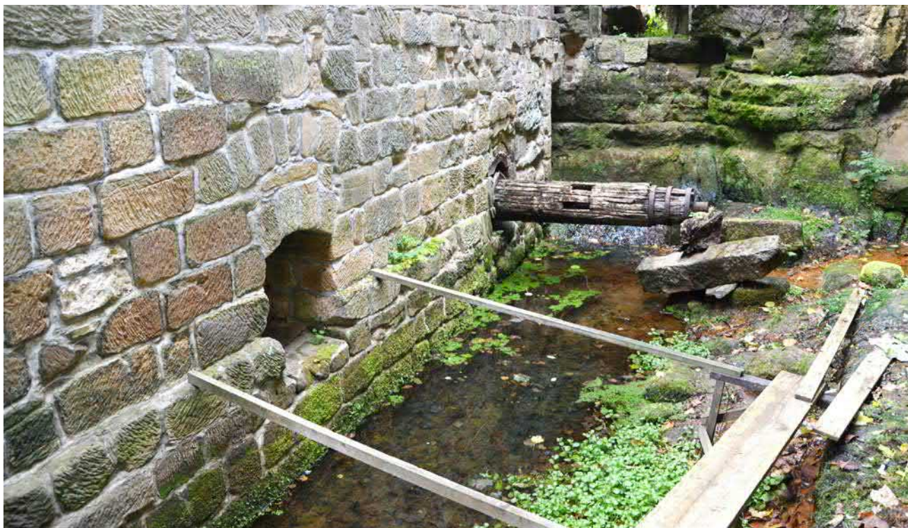
Obr. 10-20 Pohled do lednice mlýna č. p. 77 v Radvanci s hřídely vodního kola na horní vodu, vlevo otvor pro hřidel druhého druhotně přidaného vodního kola (foto Miroslav Kolka, 2019).
