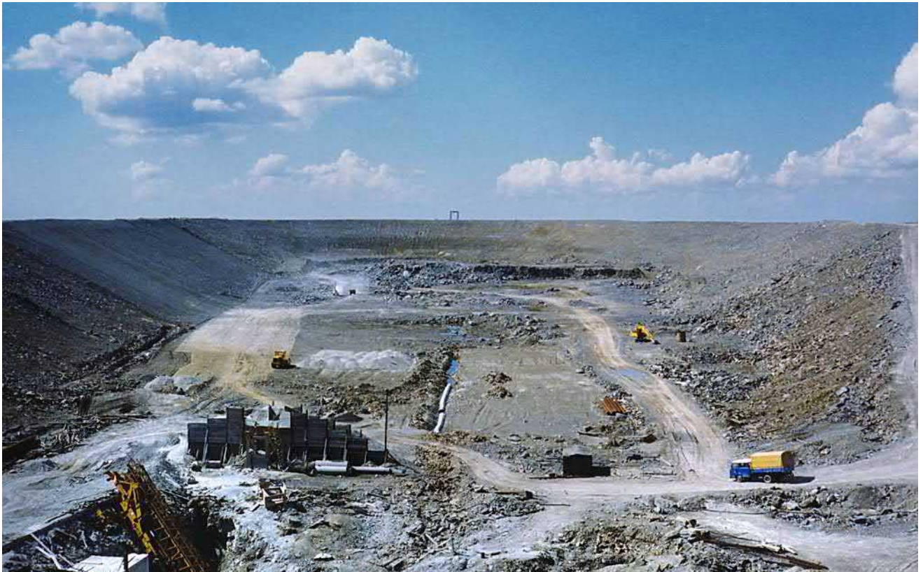
Obr. 9-26 Staveniště horní nádrže v roce 1990 (foto Jan Höll).
