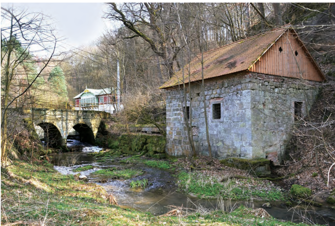
Obr. 10-11 Lvová, čerpací stanice vodovodu pro areál zámku Lemberk, vodovod byl založen v poslední třetině 17. století, čerpací stanice stojí na náhonu pod hrází Pivovarského rybníka, výpusť překlenuje dvouobloukový most z roku 1803 (foto Miroslav Kolka, 2015).
