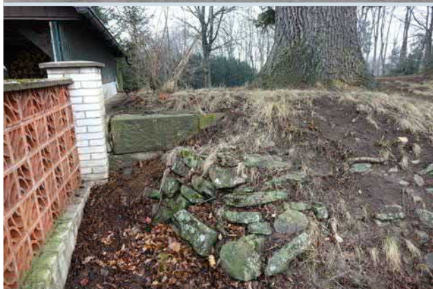
Obr. 11-41 Relikt boční hráze Zbýšovského rybníka (nahore) a chata vystavěna na místě bývalého splavu. Dole detail bývalého tarasu hráze a kamenného obložení splavu (foto Jindřich Frajer st., 2022).
