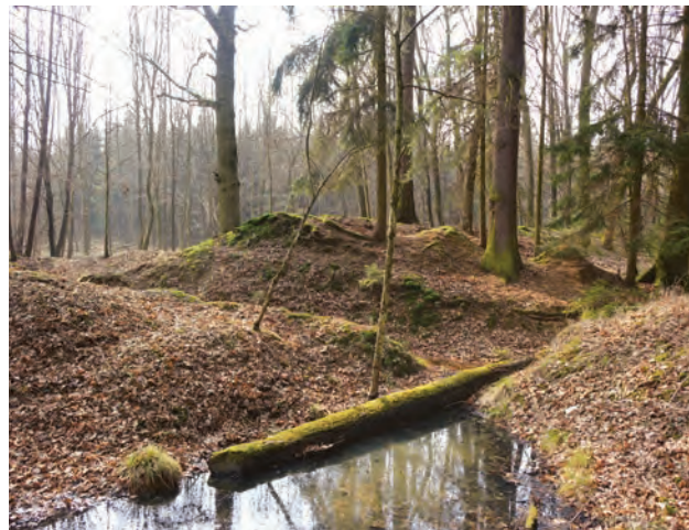
Obr. 11-31 Prokopaná hráz Malého Komárovského rybníka (foto Jindřich Frajer st., 2022).
