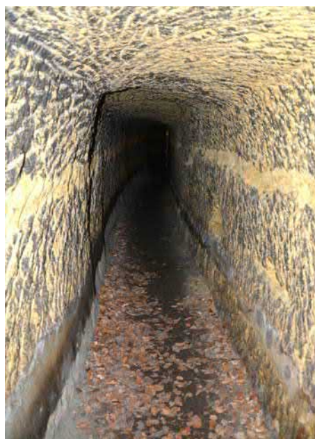
Obr. 10-19 Hamr u Naděje, vodní dílo pily č. p. 51, po přístavbě nové pily kolem roku 1920 byl náhon prodloužen do skalní štoly (foto Miroslav Kolka, 2019).
