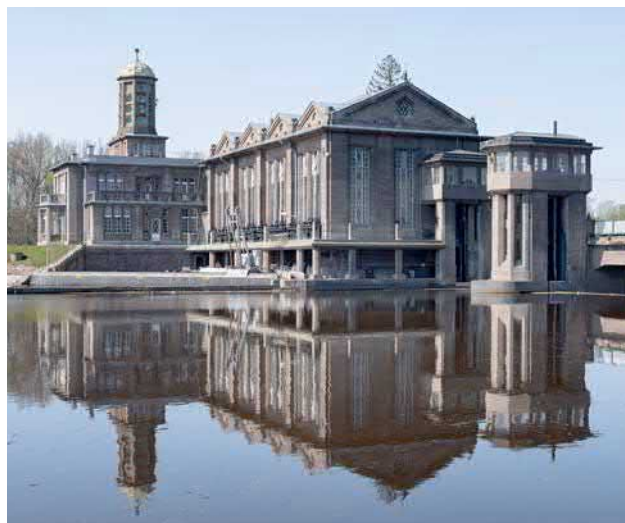
Obr. 3-14 Poděbrady, jez, plavební komora a vodní elektrárna (KP, NKP), vystavěné v letech 1914–1924 (foto Viktor Mácha).
