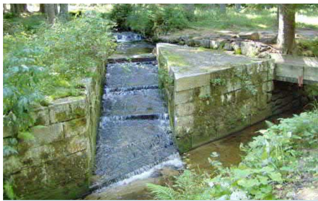
Obr. 3-13 Schwarzenberský plavební kanál (KP, NKP) pro plavení dřeva ze šumavských lesů. Pravidelná plavba trvala do roku 1891, na české straně se plavilo do roku 1961. Koryto kanálu je obloženo trámy, žulovými deskami nebo je tesáno ve skále. Součástí jsou také křižení s potoky a cestami, tunely apod. (foto Eva Dvořáková).
