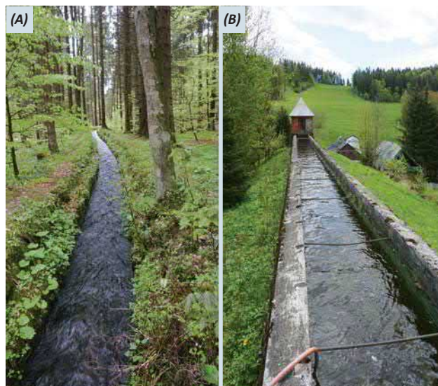
Obr. 8-8 Část vodohospodářského komplexu Anenské huti ve Staré Vsi – (A) náhon od Stříbrného potoka, (B) betonové koryto přivádějící vodu ke kašně malé vodní elektrárny (foto Martin Caletka, 2021).
