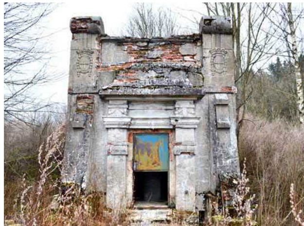
Obr. 10-10 Bohatice u Zákup, vodojem sloužící k zásobování Zákup vodou, vodovod byl vystavěn mezi lety 1913–1914 podle plánů firmy L. Bill & Comp. z Podmokel (dnes součást Děčína), ve vodojemu se shromažďovala voda z prameniště na hranicích katastrů Bohatic a Pertoltic pod Ralskem, z vodojemu se pak gravitačně vedla do Zákup (foto Miroslav Kolka, 2014).
