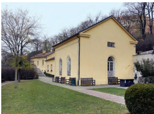
Obr. 3-9 Brno, bývalá parní čerpací stanice na Špilberku (KP), vybudovaná spolu se zemním vodojemem vloženým do bastionu hradební pevnosti, je dnes chráněna jako součást zahradnictví v areálu hradu Špilberk (foto Michaela Ryšková, 2021).
