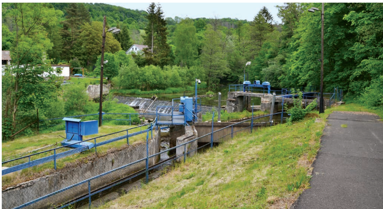
Obr. 10-34 Františkov nad Ploučnicí, elektrárna č. p. 132, pohled na jez (foto Miroslav Kolka, 2022).
