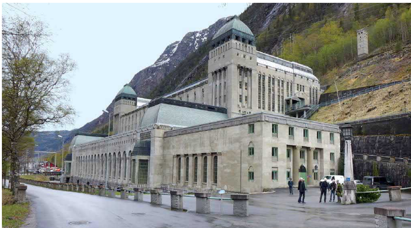
Obr. 3-16 Rjukan–Notodden, vodní elektrárna Sâheim (foto Michaela Ryšková, 2015).
