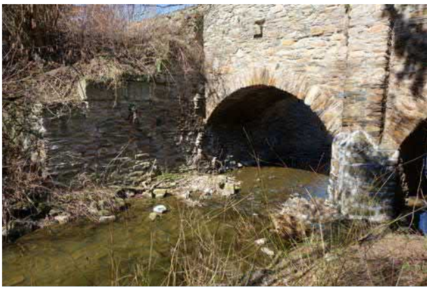
Obr. 11-23 Most přes Brslenku vybudovaný po r. 1861, nacházející se v místě bývalého splavu z rybníka Svornost. Dole detail reliktu splavu rybníka – kamenné opevnění (foto Jindřich Frajer st., 2022).
