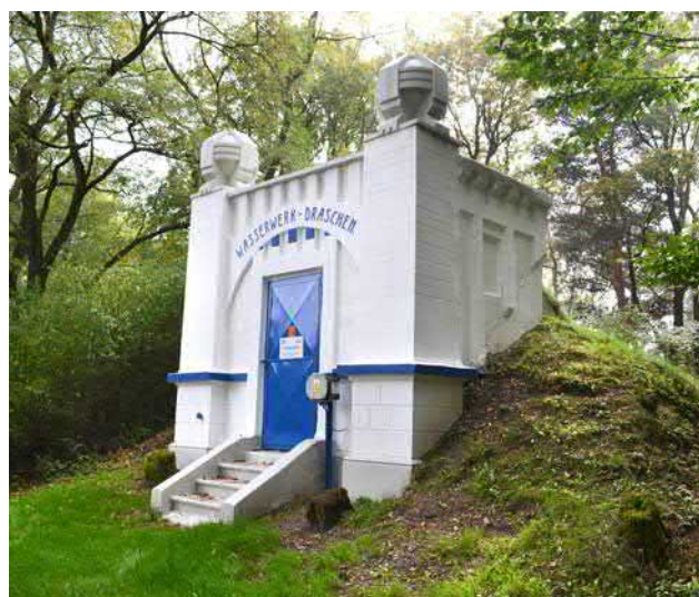
Obr. 10-25 Nadále funkční vodojem vodovodu v Dražejově (foto Miroslav Kolka, 2014).
