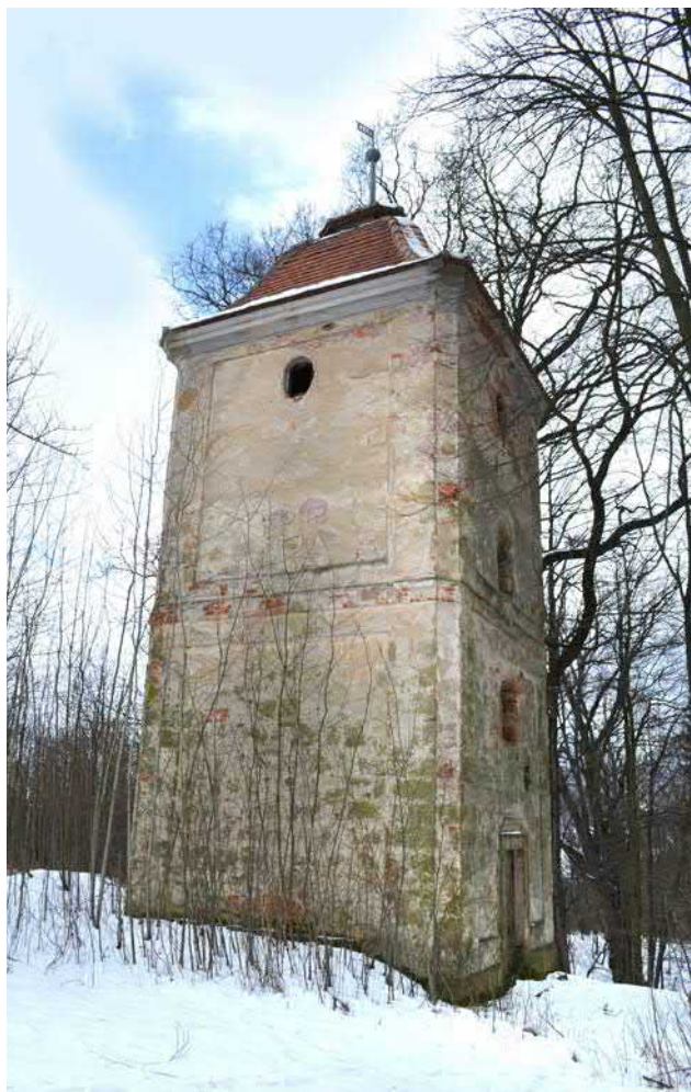
Obr. 10-12 Lvová, vodárenská věž (vodojem) vodovodu pro areál zámku Lemberk, pochází z roku 1734 a stojí nad čerpací stanicí na zámeckém návrší naproti Bredovské zahradě (foto Miroslav Kolka, 2015).
