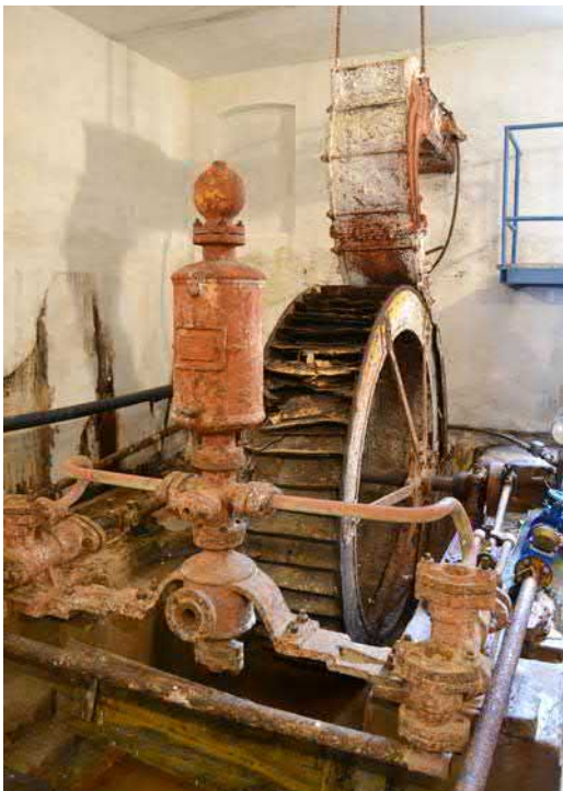
Obr. 10-30 Snímek unikátně zachovaného zařízení čerpací stanice pro Pavlovice ještě na původním místě před rozebráním a deponováním. Vpředu dvojice ležatých pístových čerpadel se vzdušníkem a za nimi vodní kolo s vantrokovým žlabem (foto Miroslav Kolka, 2014).
