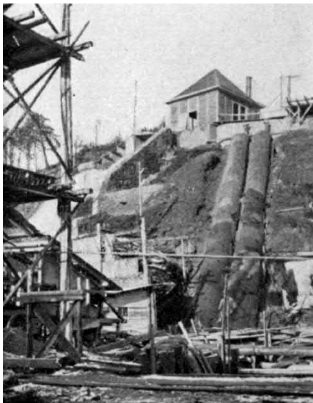
Obr. 8-27 Nový vtokový objekt a přívodní betonové roury k Francisovým turbínám, rok 1926 (SOKA Opava).
