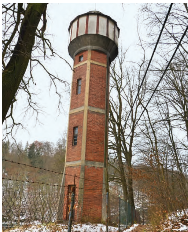
Obr. 10-40 Františkov nad Ploučnicí, přádelna č. p. 25, vodojem sprinklerového systému (foto Miroslav Kolka, 2021).
