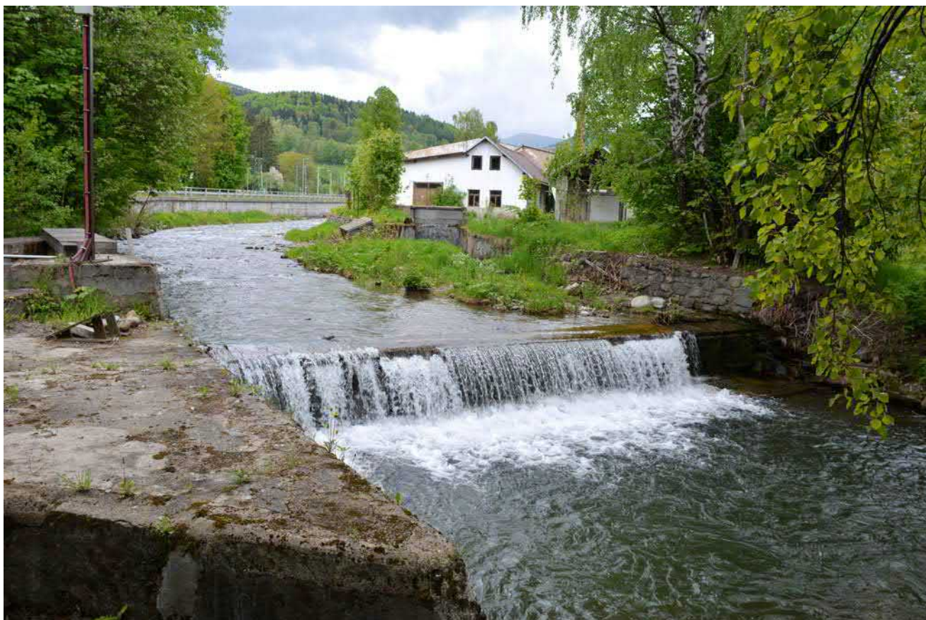
Obr. 9-2 Řeka Desná v Rejhoticích – regulovaný tok s jezem a s náhonem na MVE Rejhotice III (foto Renata Pavelková, 2021).
