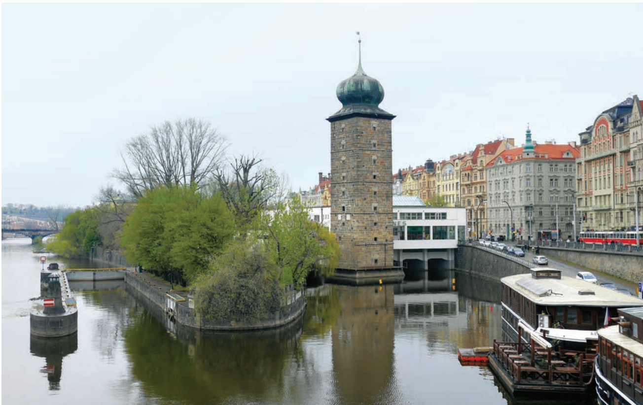
Obr. 3-5 Praha, Novoměstská Šitkovská vodárenská věž (KP) z lomového kamenného zdiva s pískovcovým obkladem byla postavena v letech 1588–1591 spolu s mlýny a brusírnou nástrojů. Strojovna čerpací stanice přiléhala na severní straně. Tvar střechy získala věž roku 1651. Provoz ukončila v roce 1881, roku 1926 byla odkoupena spolkem Mánes, mlýny byly zbořeny a na jejich místě postavena budova a výstavní síň (foto Michaela Ryšková, 2022).
