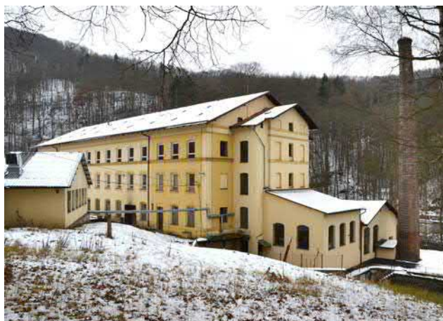
Obr. 10-39 Františkov nad Ploučnicí, přádelna č. p. 25, pohled na přádelnu se strojovnou, kotelnou a továrním komínem (foto Miroslav Kolka, 2021).
