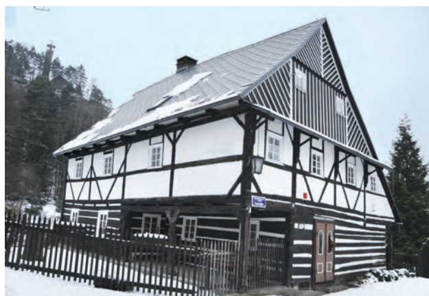
Obr. 10-5 Sloup v Čechách, mlýn č. p. 117, pochází z doby kolem roku 1757 a kombinuje roubené přízemí s podstávkou u obytné části, hrázděné patro a velmi zajímavou podsíň, mlýnice je umístěna za podsíň a zabírá celou pravou polovinu stavby (foto Miroslav Kolka, 2021).
