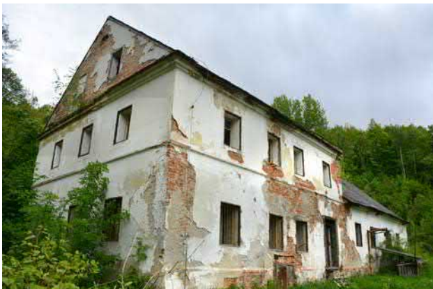
Obr. 9-6 Současný stav objektu Schilderova mlýna (foto Renata Pavelková, 2021).
