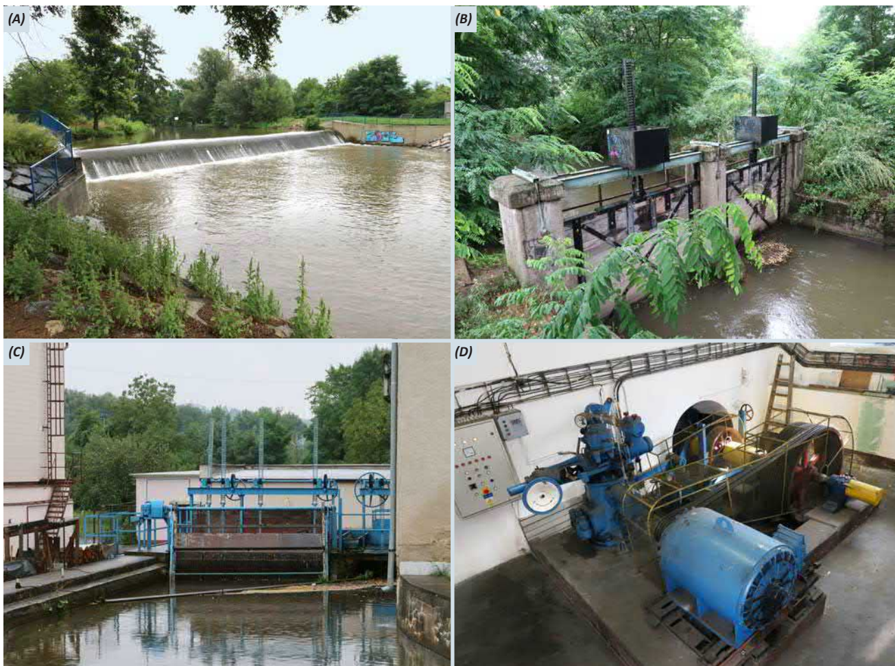
Obr. 7-17 Malá vodní elektrárna v Brně-Cacovicích – (A) jez na Svitavě, (B) hradící objekt na počátku náhonu, (C) vtok náhonu do turbíny a jalová propust, (D) interiér strojovny (foto A–C Miriam Dzuráková, D Martin Caletka, 2020).
