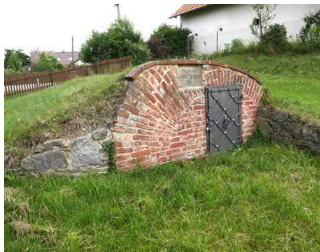
Obr. 3-6 Srch, zemní vodojem (KP) (foto Michaela Ryšková, 2022).
