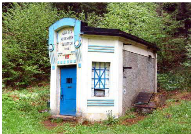
Obr. 10-26 Čerpací stanice vodovodu pro Dřevčice, umístěná v údolí Dolského potoka (foto Miroslav Kolka, 2012).
