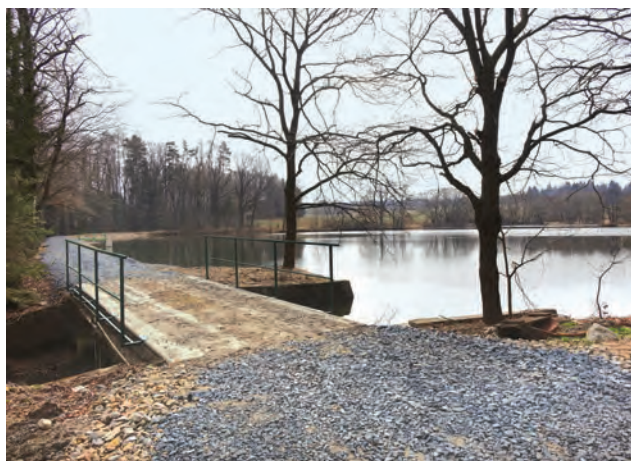
Obr. 11-28 Rybník Mokeř. V popředí jalový splav z rybníka (foto Jindřich Frajer st., 2022).
