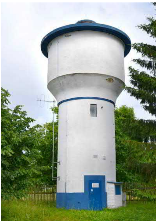
Obr. 10-32 Věžový vodojem vodovodu v Loubí (foto Miroslav Kolka, 2017).
