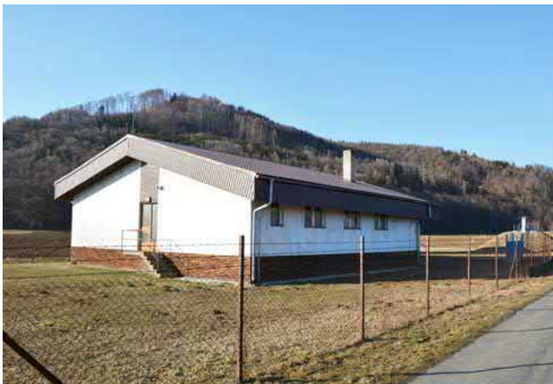
Obr. 9-20 Úpravna vody Rapotín s objektem jímací studny (foto Aleš Létal, 2022).
