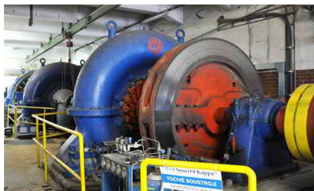
Obr. 8-26 Původní Francisovy turbíny a generátor z roku 1926 stále v provozu (foto Miriam Dzuráková, 2019).
