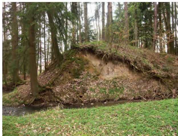
Obr. 11-32 Prokopaný profil hráze Velkého Komárovského rybníka s korytem Klejnárky (Jánské potoka). Návodní strana hráze vpravo (foto Jindřich Frajer, 2018).
