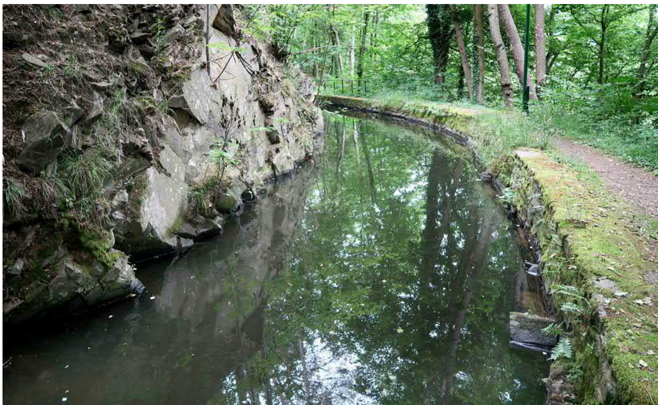
Obr. 8-32 Snaha o udržení původního vzhledu náhonu – pravý břeh z kamenného zdiva (foto Radka Račoch, 2021).
