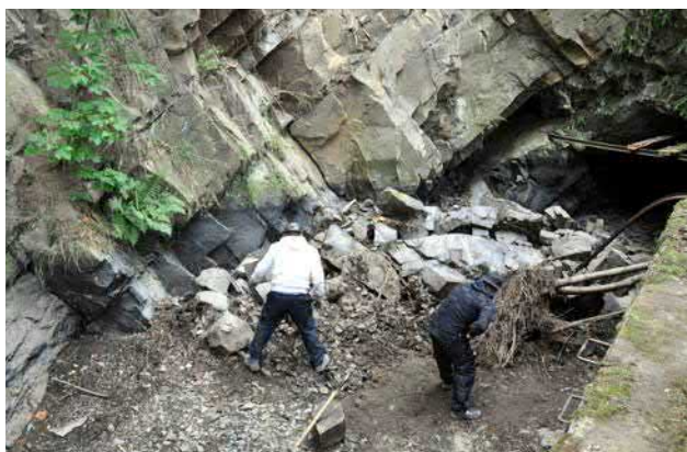
Obr. 8-30 Pravidelná údržba a čištění náhonu (foto Miriam Dzuráková, 2019).
