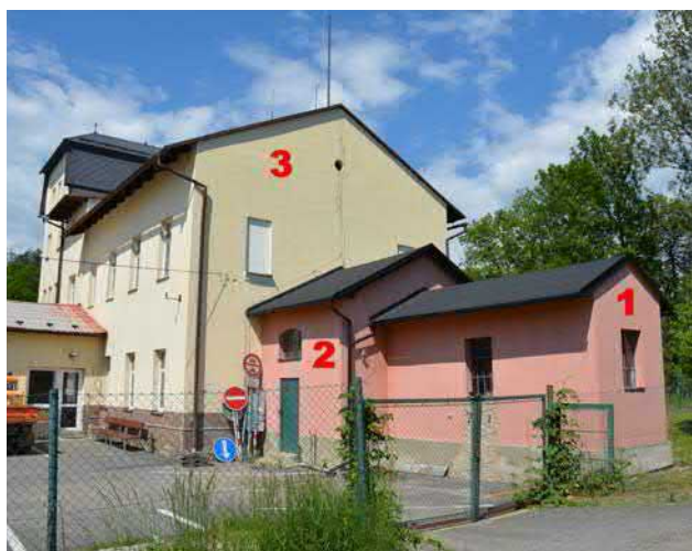
Obr. 9-13 Současná podoba bývalé vodárny se studnou (1), sekci pro elektrická čerpadla (2) a původní strojovnou (3) (foto Aleš Létal, 2021).
