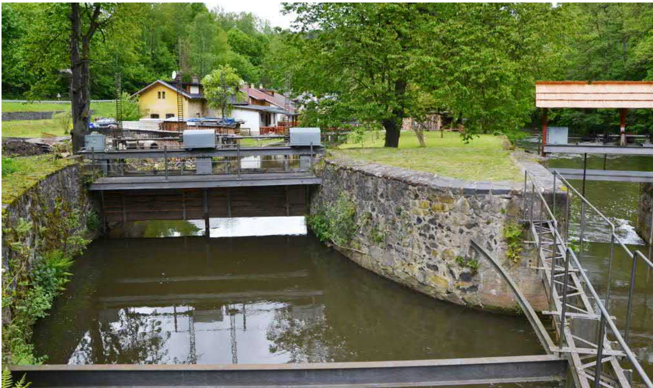
Obr. 10-41 Benešov nad Ploučnicí, přádelna č. p. 705, jez a nátok se stavidly do náhonu, v pozadí na břehu náhonu dělnická kolonie (foto Miroslav Kolka, 2021).
