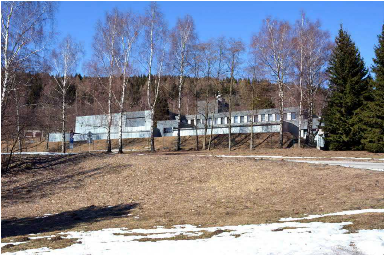
Obr. 9-17 Objekt úpravný vody v Koutech po rekonstrukci v roce 2009 (foto Aleš Létal, 2021).
