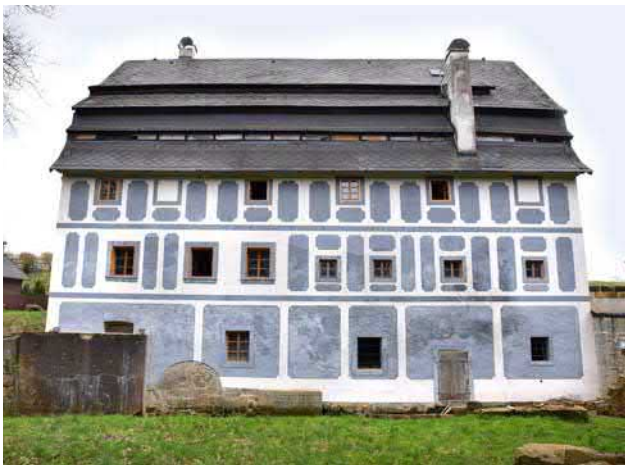
Obr. 10-9 Hamr na Jezeře, papírna č. p. 5, mezi stavby nepochybně převyšující svým významem hranice oblasti bezpochyby náleží tato unikátně zachovaná papírna s torzy strojního zařízení z přelomu 19. a 20. století, objekt se zděným přízemím a hrázděným patrem pochází z 80. let 17. století (foto Miroslav Kolka, 2017).
