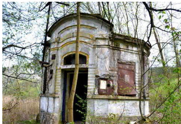
Obr. 10-24 Čerpací stanice vodovodu v Dražejově v Pramenném dole. Objekt je dnes již nefunkční, v interiéru jsou dochovány otisky po umístění turbíny, ležatého pístového čerpadla a vzdušníku (foto Miroslav Kolka, 2014).
