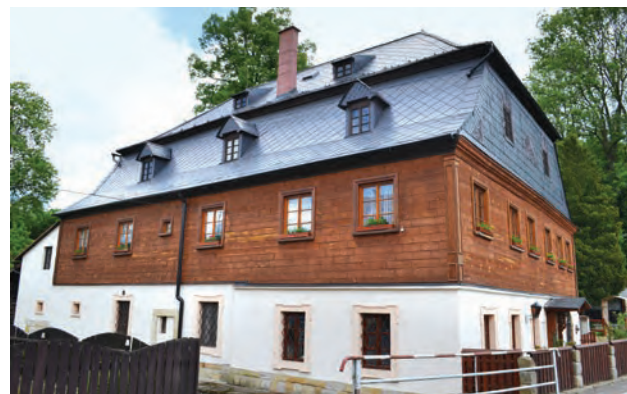
Obr. 10-7 Skalice u České Lípy, mlýn č. p. 269, velmi dobře zachovaná budova pozdně barokního mlýna z doby kolem roku 1762, přízemí je zděné a patro roubené s regionálně typickým obložením (foto Miroslav Kolka, 2017).
