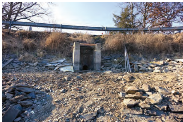
Obr. 11-37 Pomocná výpust Zbýšovského rybníka – původně vedoucí na mlýnský náhon (foto Jindřich Frajer st., 2022).
