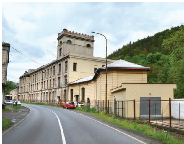
Obr. 10-42 Benešov nad Ploučnicí, přádelna č. p. 705, celkový pohled, v popředí strojovna s kotelnou (foto Miroslav Kolka, 2021).
