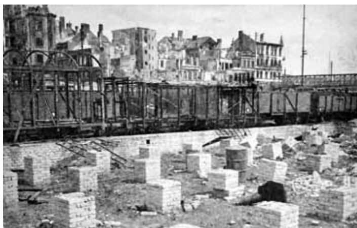
Zničený sklad na Horním nádraží, v pozadí Jáchymovská ulice
