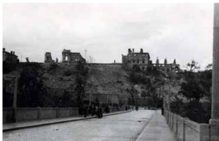
Zcela zničené Horní nádraží od Ostrovského mostu
