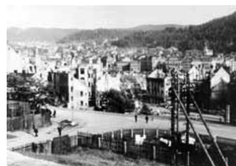
Pohled od viaduktu k Sokolovské 1946
