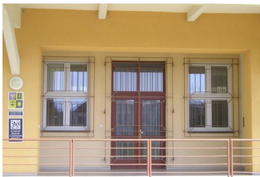
Obr. 50: Zabezpečení oken a dveří
