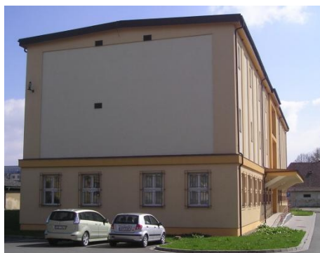
Obr. 49: Boční pohled na budovu
