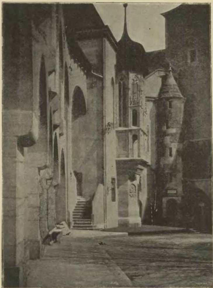
Arkýřová kaple ve Vlaském Dvoře v Hoře Kutné po obnově.
