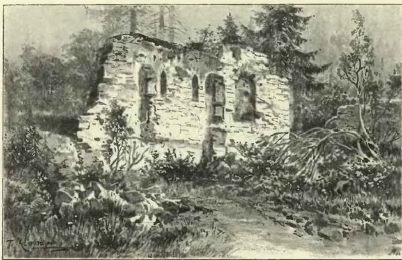
Pohled na zbytky hlavního stavení Karlshausu.
