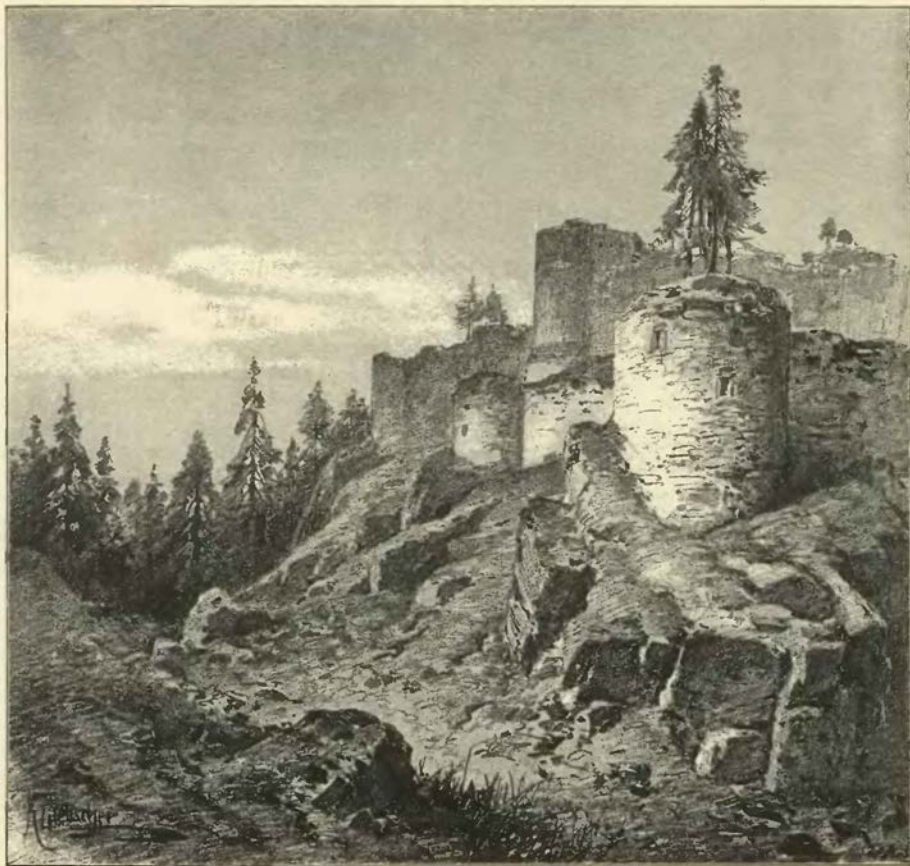
Bašty na jihovýchodní straně Helfenburka.
