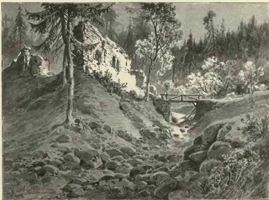
Karlshaus. Pohled zvenčí.
