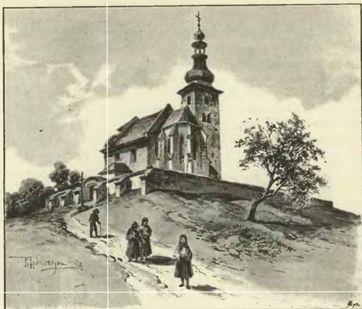
Kostel v Kostelci Zeleném od východu.
