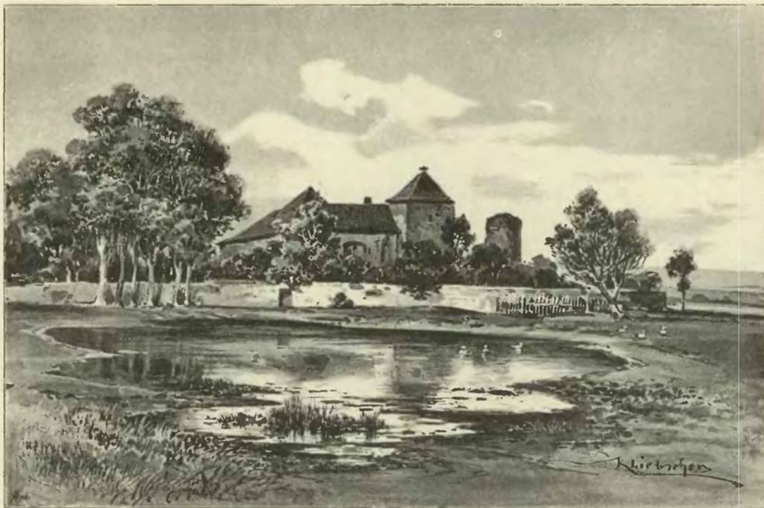
Horní tvrz v Kestřanech. Pohled zvenčí.
