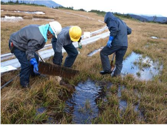
① 排水不良になっている箇所は、下側の土留板を撤去するなどして、排水路をできるだけ確保する (St. 09-01) * 植被が見られる部分は、実験区脇の裸地に表土の泥炭ごと移植する
