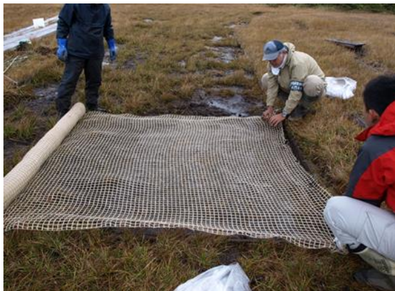
⑧a 植生ネットで覆う (St. 09-01) * 2015・2016年は、播種・散布後にヌマガヤの枯葉を敷いた後に植生ネットを掛けたが、2017年以降は植生ネットを用いなくなった
