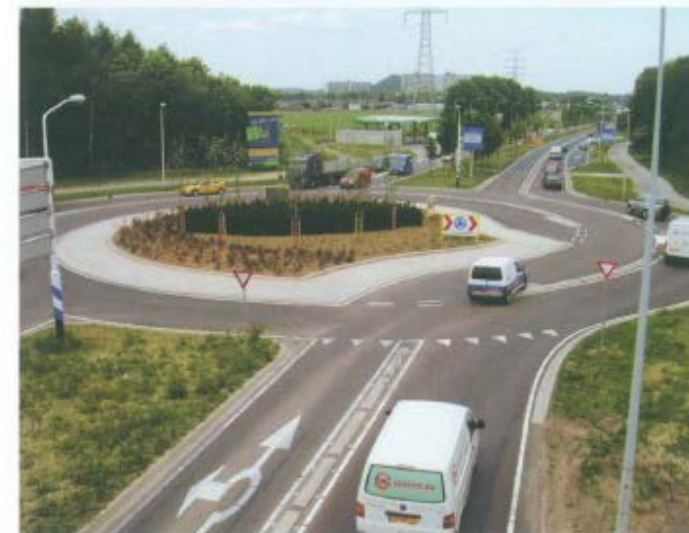
Figuur 112. Belijning op de rotonde, aan beide zijden van elke rijstrook [Heerlen Imstenraderweg – N281]
