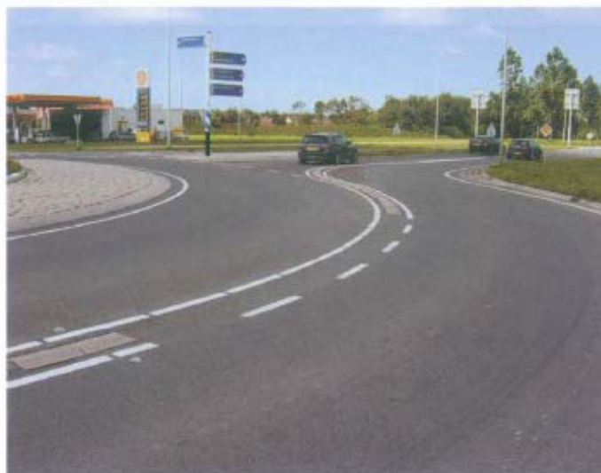
Figuur 110. Als het verkeer een reeds gekozen rijstrook moet volgen, wordt een combinatie van een doorgetrokken en een onderbroken streep toegepast [N218 Oostvoorne]
