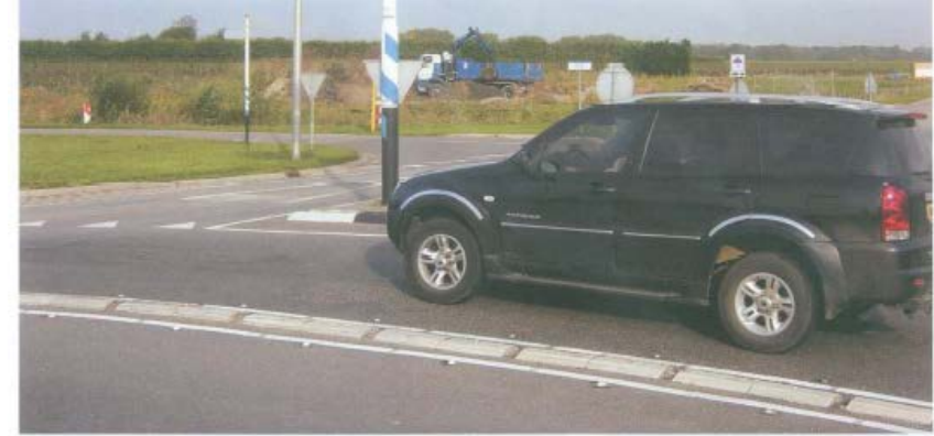
Figuur 67. Verhoogde scheidsband met belijning en reflectoren [N218 Brielle]
