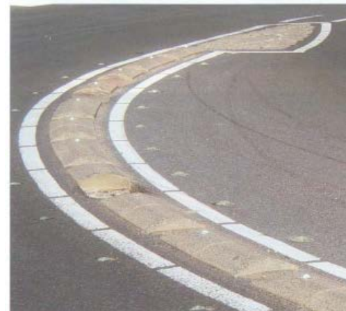
Figuur 68. Het is duidelijk wat de consequenties zijn als de scheidsbanden niet worden verzonken in het wegdek, maar erop geplakt worden [Veghel Corridor-Kennedylaan]
