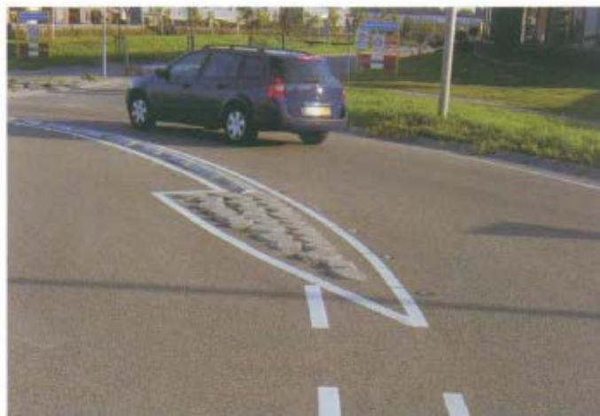
Figuur 109. Als tegenover de toerit een nieuwe binnenste rijstrook ont-springt, begint de belijning van het overrijdbare gedeelte tussen de rij-stroken bij de verkeersdruppel [N472 Bergschenhoek]
