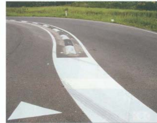
Figuur 69. De voorkeursoplossing, met reflectoren op de scheidsband en tussen de scheidsband en de belijning
