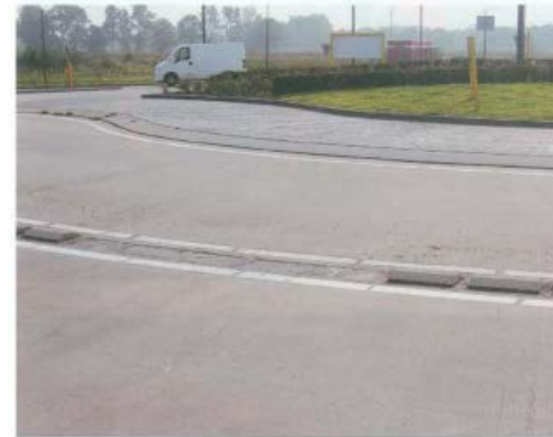
Figuur 68. Het is duidelijk wat de consequenties zijn als de scheidsbanden niet worden verzonken in het wegdek, maar erop geplakt worden [Veghel Corridor-Kennedylaan]
