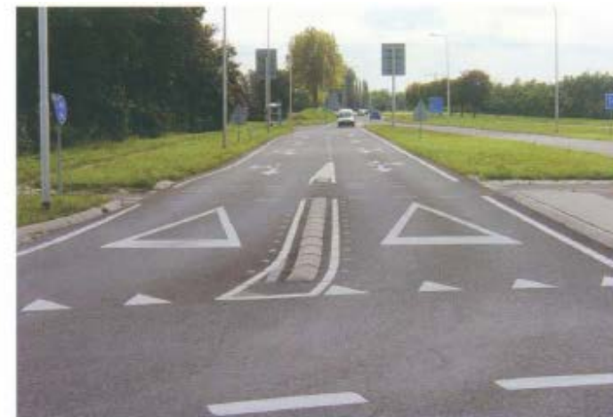
Figuur 111. Belijning vóór de rotonde, langs de rijstrookscheiding [N218 Oostvoorne]
