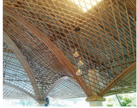
Figura 65. Cielo raso de bambucillo, restaurante Las Turunas, La Merced – Chanchamayo.
