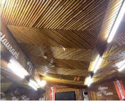
Figura 64. Cielo raso de bambucillo, restaurante El Edén, La Merced – Chanchamayo.
