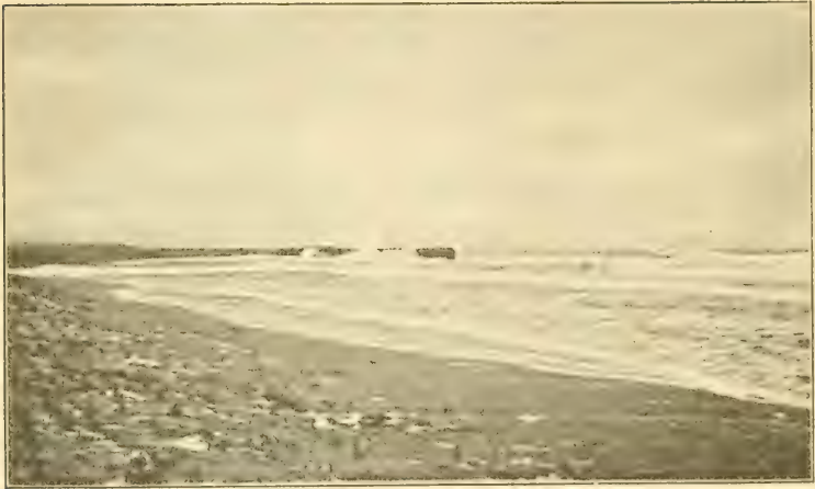
Sturmflut auf Baltrum gegen das Pallisadenwerk anschlagend.
