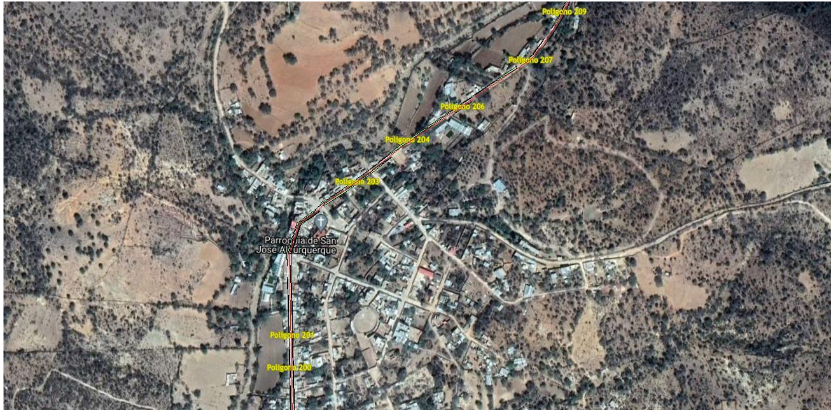
Figura-45 Polígonos de afectación, parte 018
