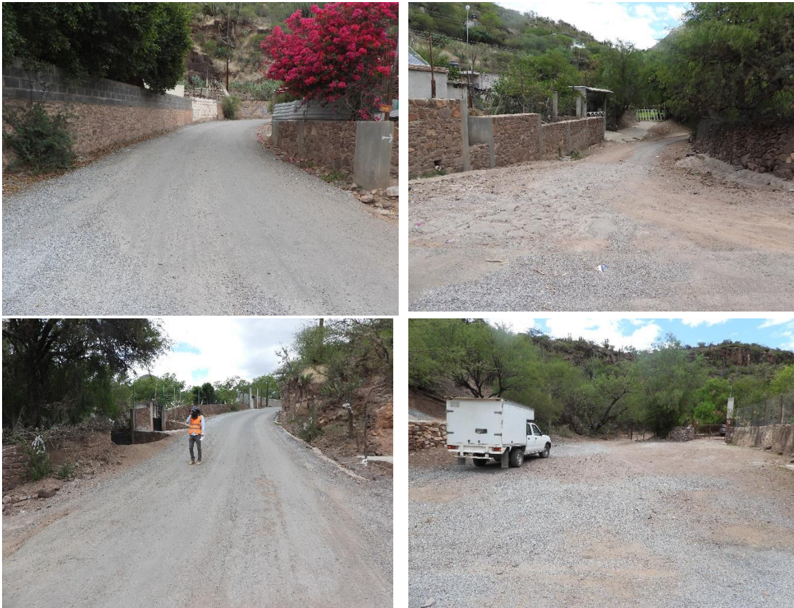
Imágenes de áreas dentro de la mancha urbana con potencial uso para patio de maquinaria temporal
