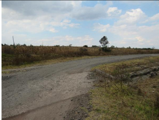
Aspecto del sitio donde se ha proyectado la obra de drenaje, existe una losa
