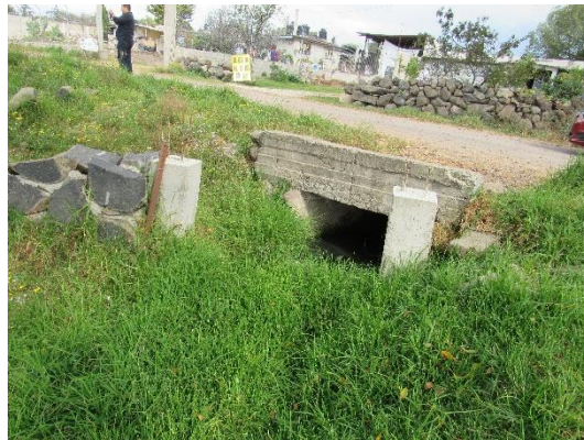
Aspecto del sitio donde se modernizará la obra
