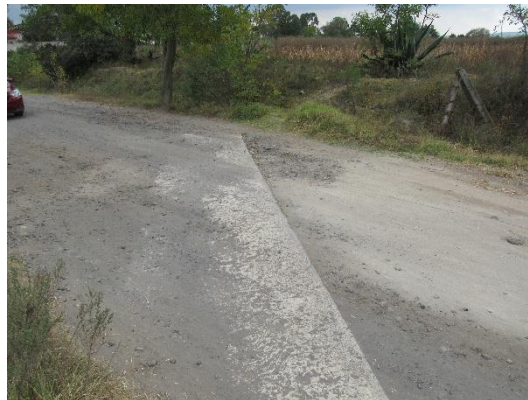
Aspecto del sitio donde se ha proyectado la obra, hay obra de drenaje actual, es una losa
