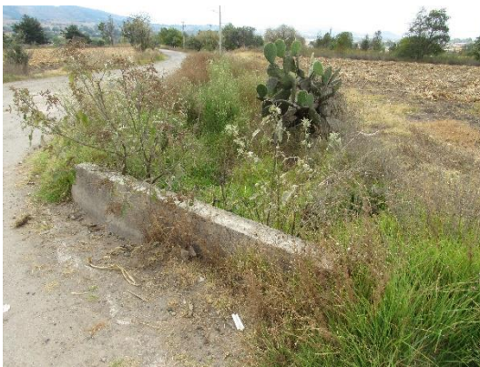
Lado izquierdo. Aspecto del sitio donde se ha proyectado la obra, hay una losa en el sitio
