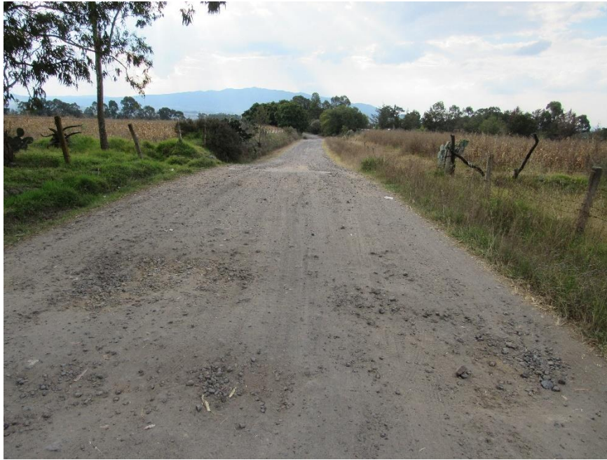
Figura 30. Parte más amplia de este subtramo, se mantiene en la zonas de afectación, cubierta de pasto
