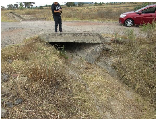
Lado izquierdo, afectación a cubierta de pasto, no se prevé afectación a algún árbol
