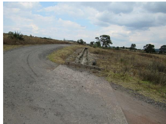
Lado derecho, afectación a cubierta de pasto, no se prevé afectación a algún árbol
