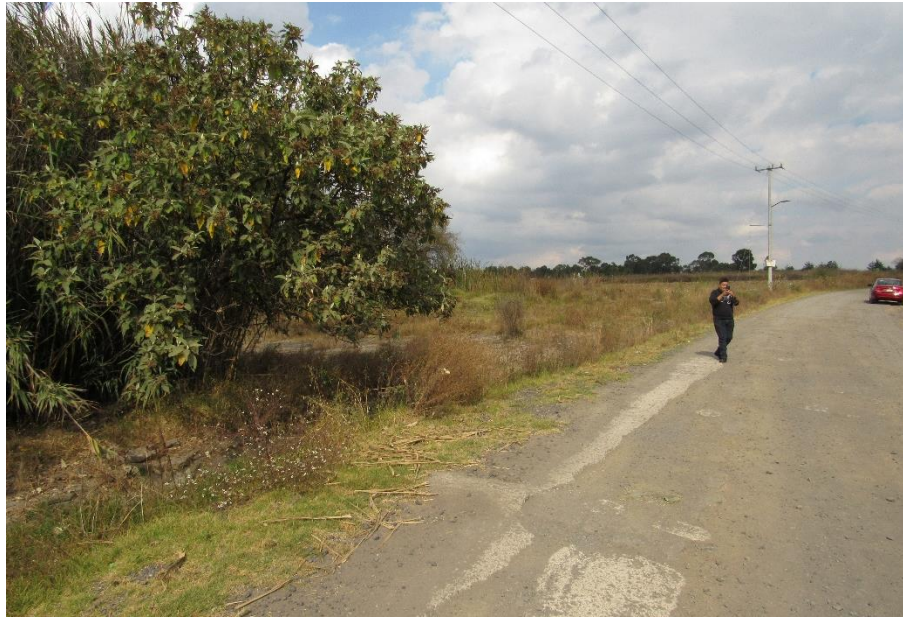
Figura 46. Aspecto general de POLAFECT_02 (lado izquierdo), la afectación se da principalmente sobre manchones de pasto, el tepozán no se prevé que sea afectado.
