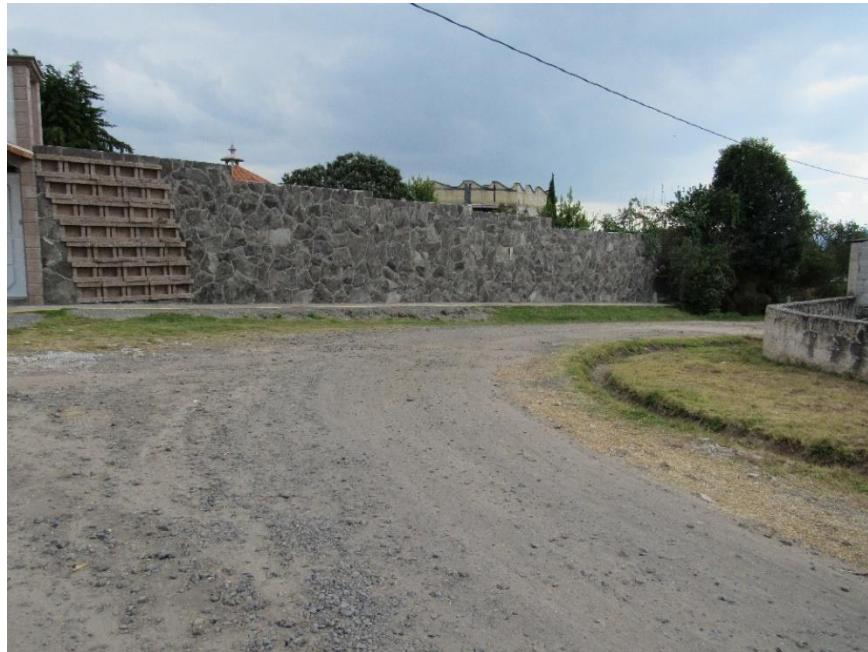
Figura 17. Curva lo suficientemente amplia para albergar las obras del Proyecto.
