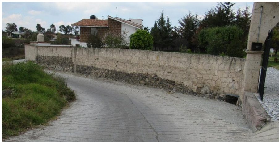
Figura 51. El POL AFECT_07 es parte de la vivienda que se observa, prácticamente no existe cubierta vegetal alguna.
