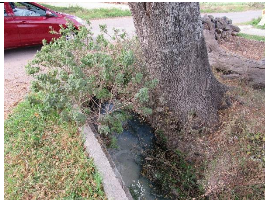
Lado derecho del sitio de la obra de drenaje, dominan los pastos, se prevé que este árbol de fresno sea afectado
