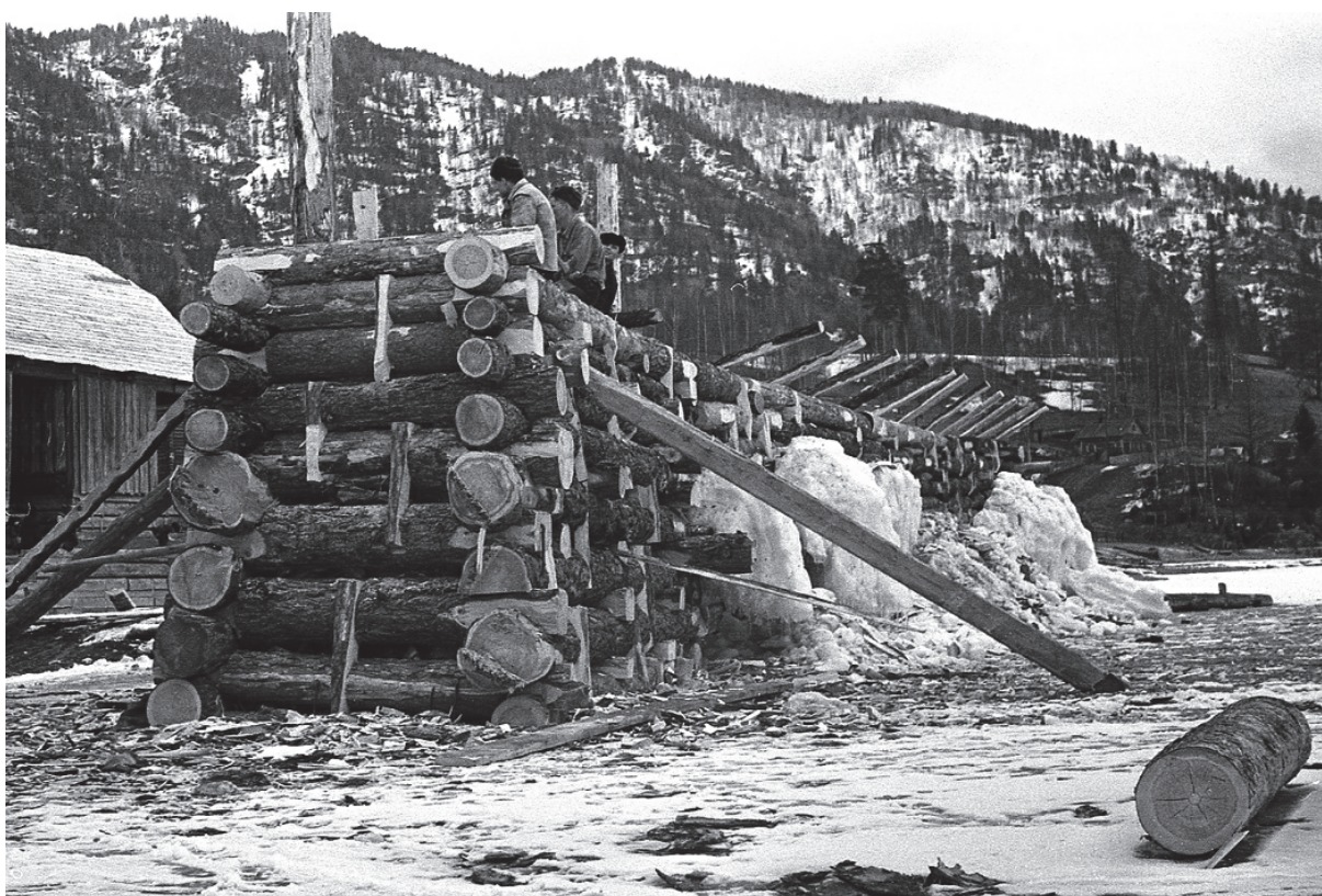
Фото 3. Строительство дамбы заповедника (декабрь 1960 г., фото Д.В. Житенёва)
