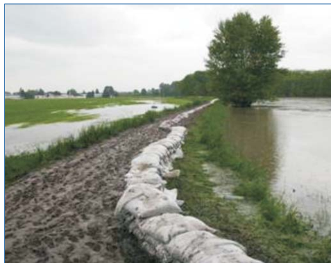
Výrazně narušené těleso hráze Cvrčov – Lobodice
