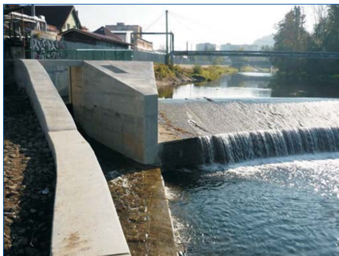
Oprava Zuberského jezu
