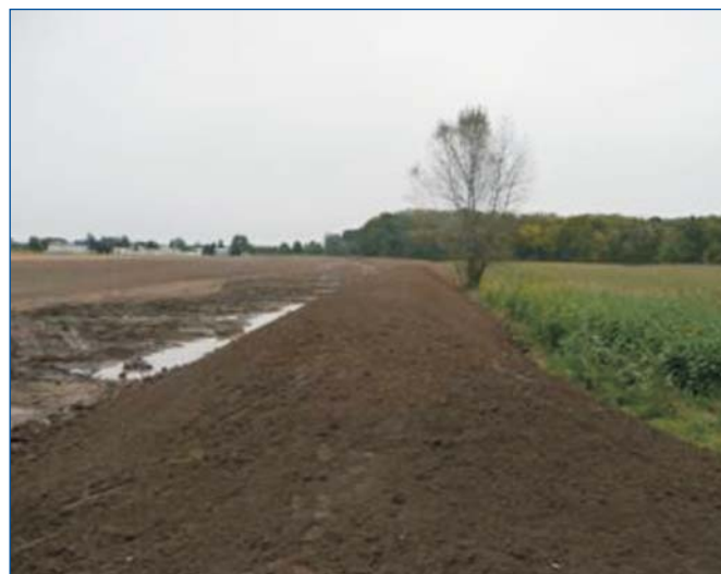
Stejný úsek hráze po opravě
