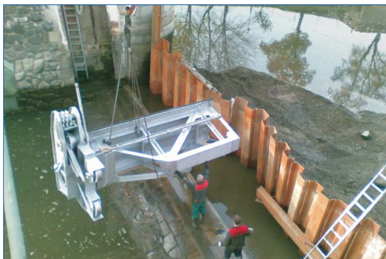
Práce na osazování jezového uzávěru
