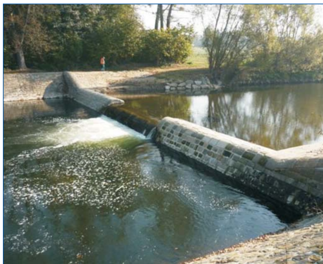
Oprava Veselského jezu
