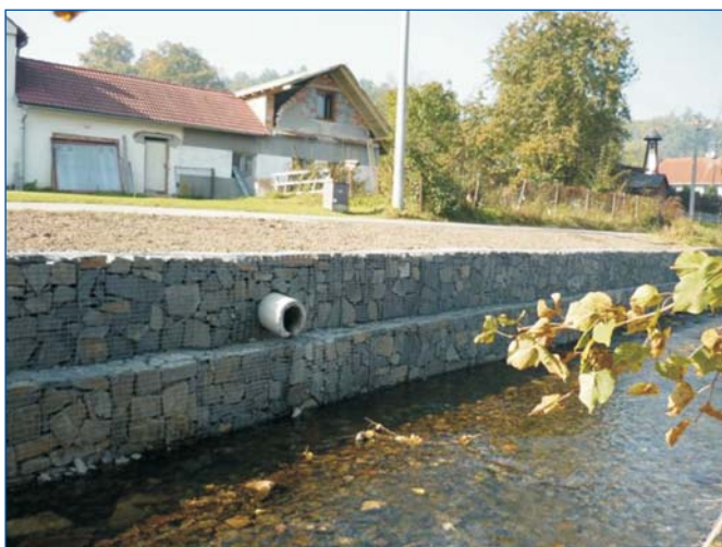
Oprava břehového opevnění ve Velké
