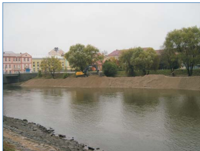
Nánosy pod jezem přemístěny ke břehu
