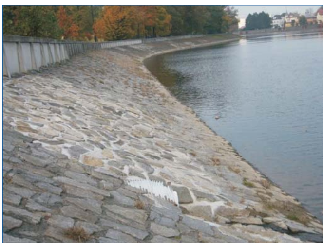
Oprava PŠ v Hranicích
