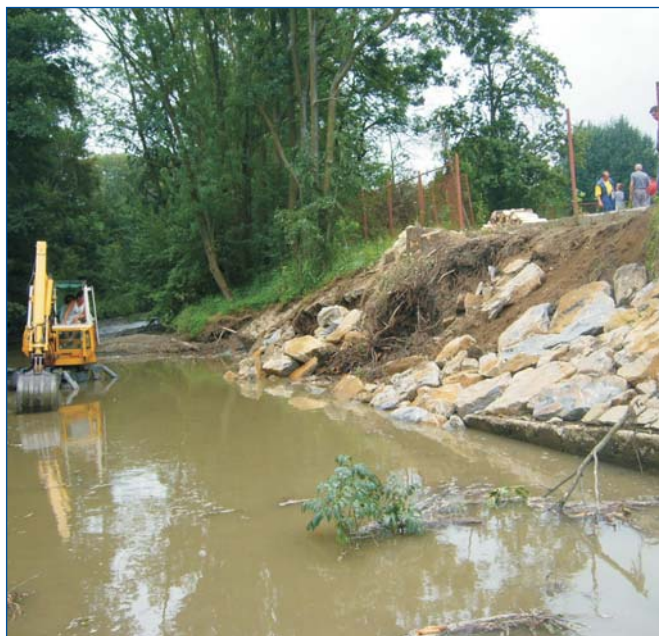
Oprava ve vodním toku Olšava
