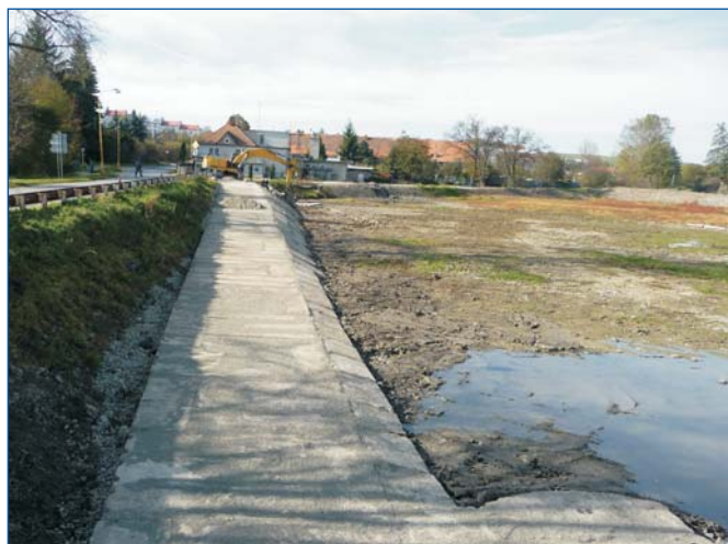
Pohled na téměř dokončený sjezd
