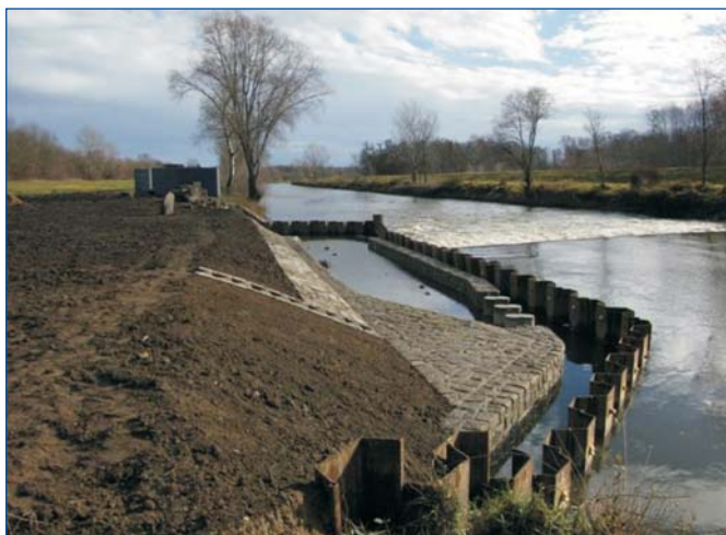
Dokončený rybí přechod na Jamborově prahu ještě pod ochranou štetové stěny
