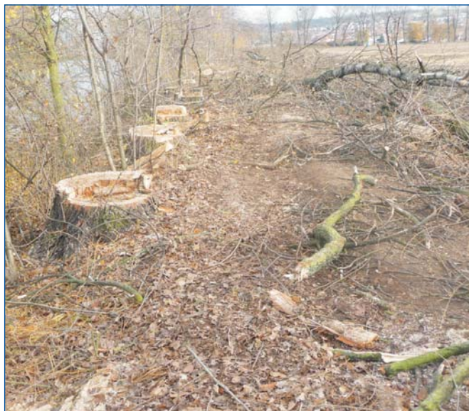
Odstranění pařezů na řece Moravě
