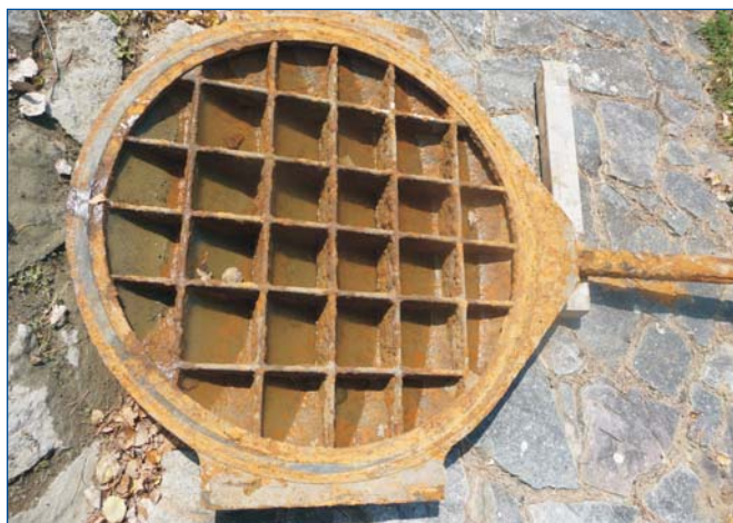
Oprava návodního uzávěru v Koryčanech
