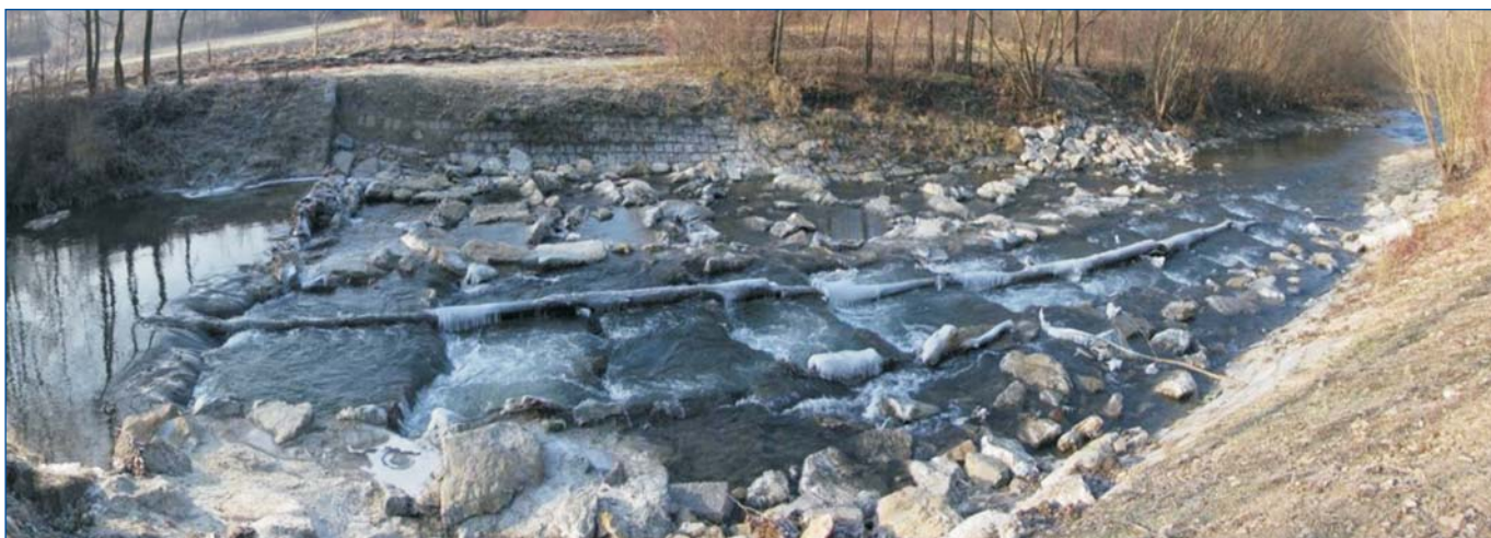
Při pohledu na tento rybí přechod na řece Veličce nás snad ani nenapadne, že se jedná o umělou stavbu a že balvanitá konstrukce pod sebou ukrývá jeden a půl metru vysoký kamenný stupeň.
