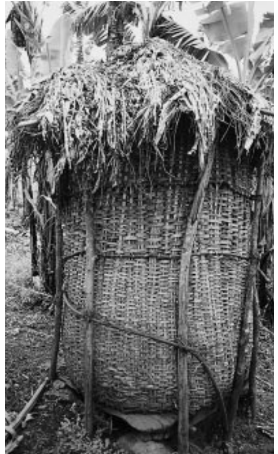
Photo 15. Dans la région du projet sont utilisés comme matériaux pour les réservoirs à grains des lianes de la forêt comme Loeseneriella apocynoides (omujega) et Imperata cylindrica pour la couverture (paroisse de Bujengwe, voisine de Kitahurira).
