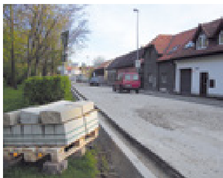
Oprava vozovky Ve Žlíbků
