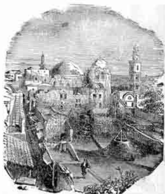
Střechy domů v Jerusalemě.
