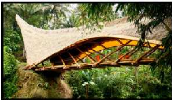
Gambar 2.1 konstruksi jembatan green school Bali
