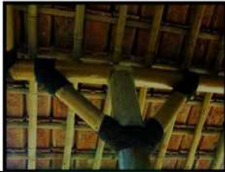
Gambar 2.1 sambungan bambu menggunakan tali ijuk
