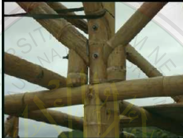
Gambar 2.1 sambungan bambu menggunakan baut
