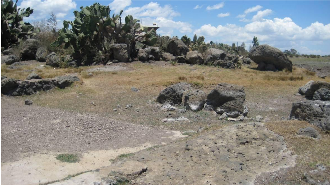
Fotografía 35. En la presa las Palmas del municipio de Acatlán, el vaso de este represo se tiene, basalto de origen fisural, el basalto con estructura en bloques.
