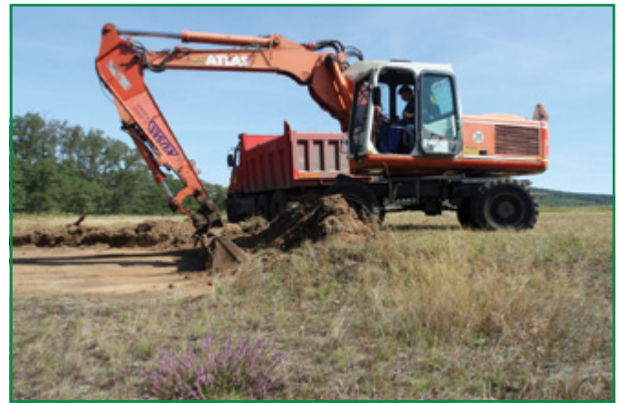
Fig. 4. Removal of the humus layer in 2009. (J. Bělohoubek)
